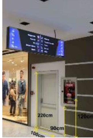
Şekil 8. Yangın Tüpü, Dolabı ve Kapısı
