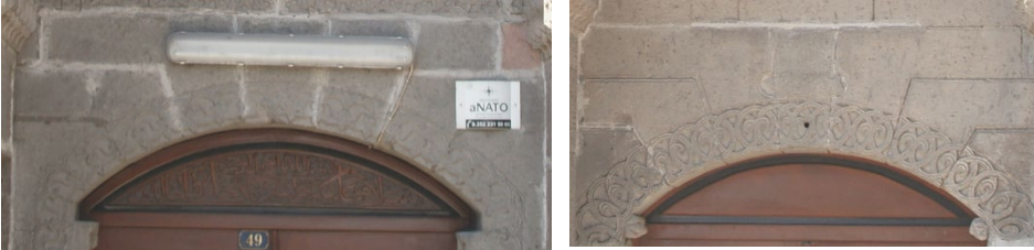
Görsel 16-17. Hacı Kılıç Camii ve Medresesi taçkapıları kemer taşları
