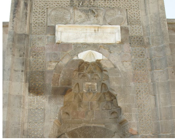
Görsel 2. Gevher Nesibe Medresesi Taçkapısı
