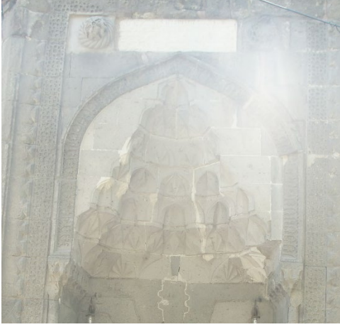
Görsel 1. Kölük Camii Taçkapısı
