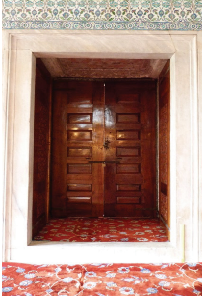
Ek 5: Sultan Ahmed Camii avlu pencerelerinden biri ve künde-kârî kanatları.
