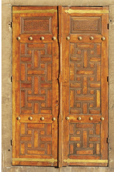
Ek 9: Sultan Ahmed Camii avlu pencerelerinden biri ve künde-kârî kanatları
