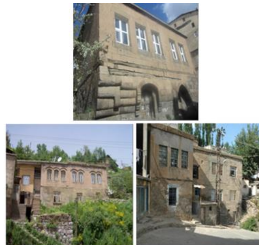
Figure 1. Masonry house examples in the region [13] (Bölgedeki yığma ev örnekleri)
