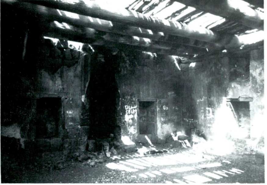
Resim 7 – Mutfađın üst örtüsü (içten).
