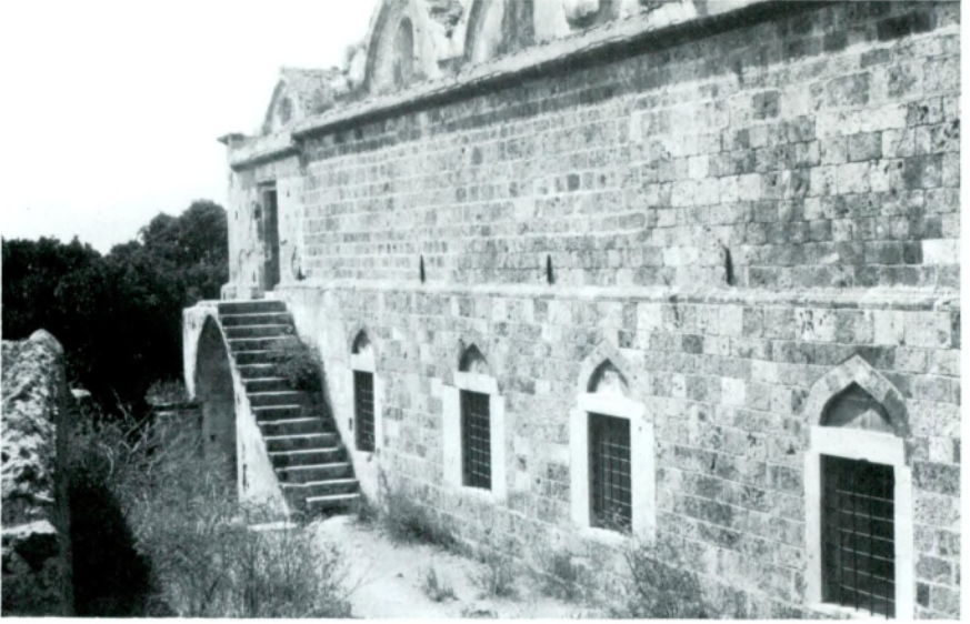
Res. 19 — Aşağı Kilise-güney yüzün genel görünüşü.
