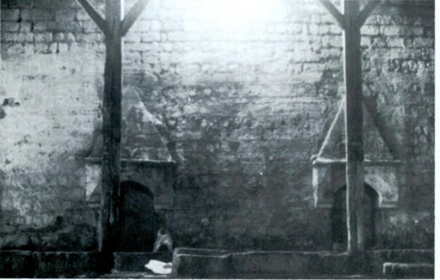
Res. 18 – Kapalı han kısmında ocak (bu ocaklar İstanbul, Arasta odalarındaki ocaklara benzemektedir). (Bkz. Ocak rölövesi şekil 16).
