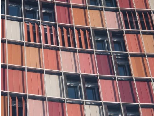
Şekil 2. Otomatik kontrollü gölgeleme elemanı
