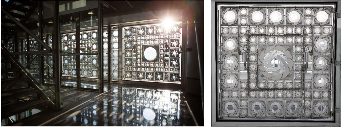
Şekil 6. Paris'teki Arap Dünyası Enstitüsü'nün uyarlanabilir gölgeleme sistemi (Hraska, 2019)
