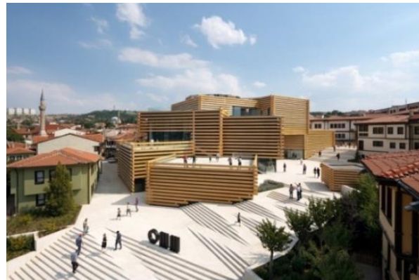
Şekil 26. Odunpazarı Modern Müze (Yapıdergisi, 2020)
