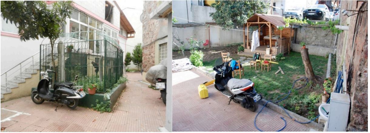
Foto. 8 Gülfem Hatun Camii'nin bahçesindeki hazire, lojman binası ve muhdes ahşap çardak (Hora Yapı Arşivi)
