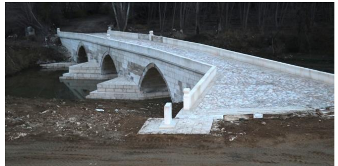
Şekil 2. Karabıyık köprüsü restorasyon sonrası görünüm
