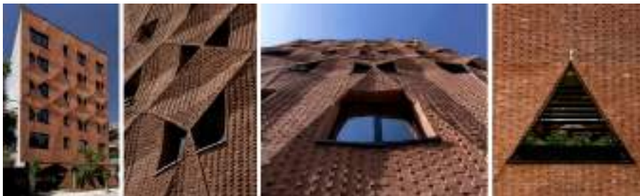
Resim 28. Terakota tuğlalardan Dış Cephe Kaplama, Tahran, İran (URL-26)
