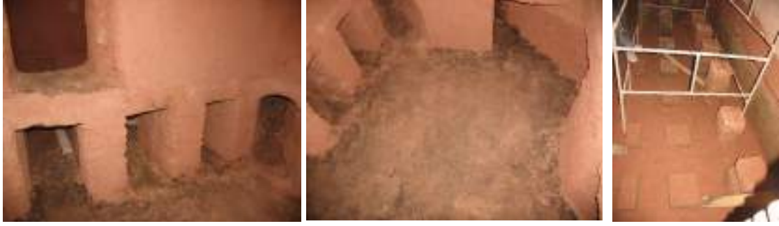
Şekil 11. Darüşşifa hamamı cehennemlik kanalları (Zemin döşemesi onarım esnasında yenilenmek üzere kaldırılmıştır) (Yazarlara ait fotoğraf arşivi, 2011)
