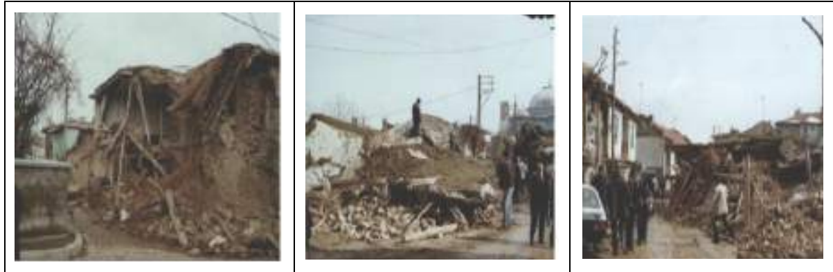
Resim 13. Konya Akşehir Bölgesi Deprem Sonrası Kerpiç Yapılar Kaynak : (Koçu vd., 2004)
