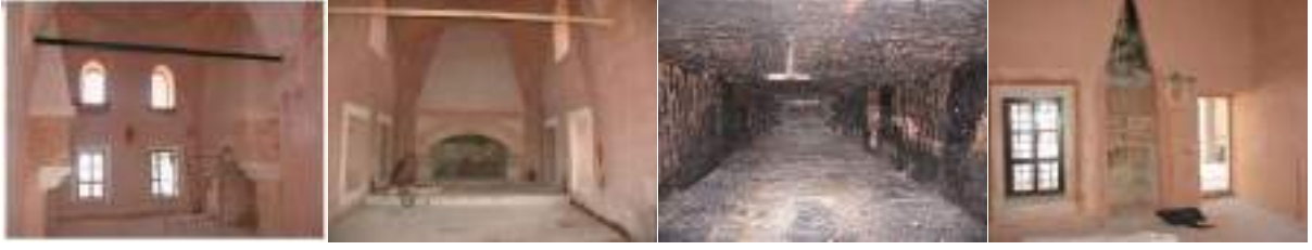
Şekil 10. Darüşşifa mutfak bölümü ocakları (solda), fodla fırını ve iç görünüşü (ortada) ile hasta odalarında duvar dibi ocak (sağda) (Yazarlara ait fotoğraf arşivi, 2011)
