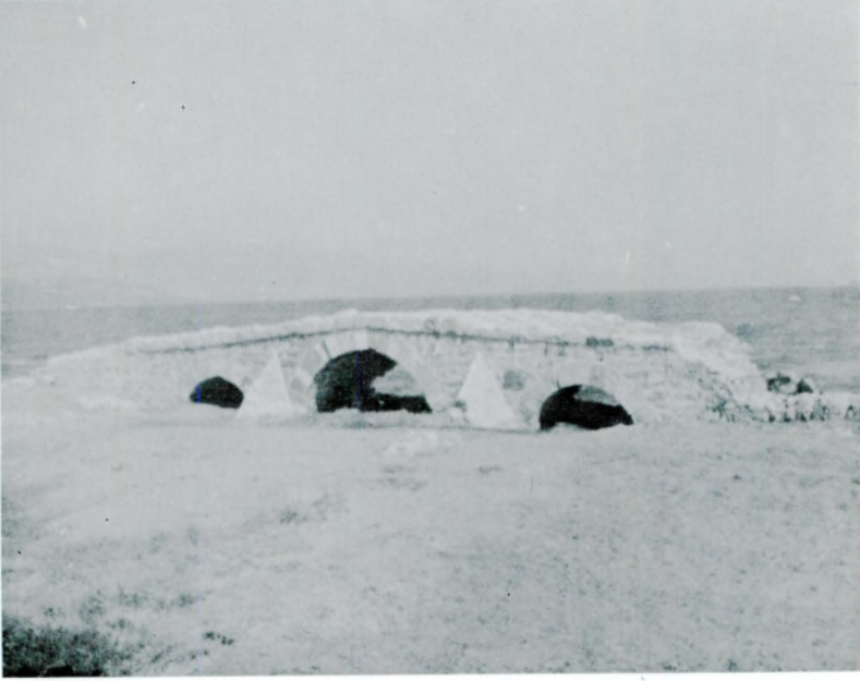
Res. 9 – Aynı yerdeki öteki köprü: 1968
