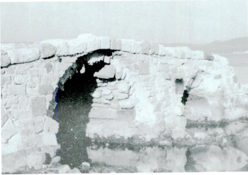
Res. 10 – Köprünün 1989 başındaki durumu
