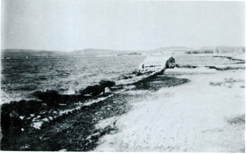
Res. 7 – Urla-İçmeler'deki yol ve köprü: 1968'de
