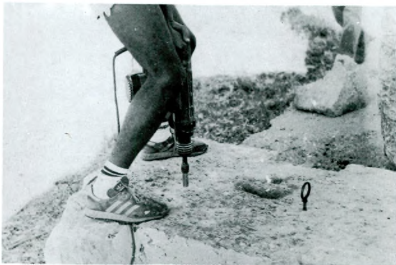
Res. 16 — Matkap kullanarak dübelin yerleştirilmesi.
