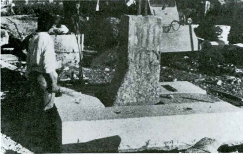
Res. 6 — Çimentolu harçla oluşturulmuş temel elemanlar (İnan'dan).
