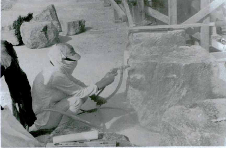
Res. 22 — Basınçlı kum püskürtülerek kırık yüzeyin temizlenmesi.
