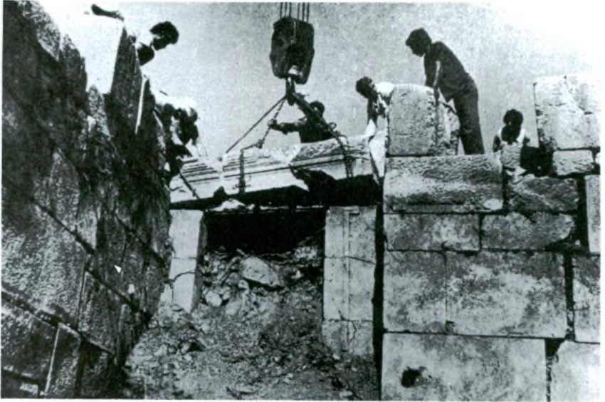
Res. 8 — Onarılan leatonun tamamen açığa çıkarılmamış şöveler üzerine oturtulması (Bayburtluoğlu'ndan).
