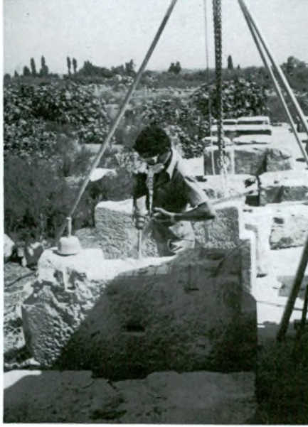
Res. 5 — Beton kolon geçirileceği düşüncesiyle ortasının oyulması.
