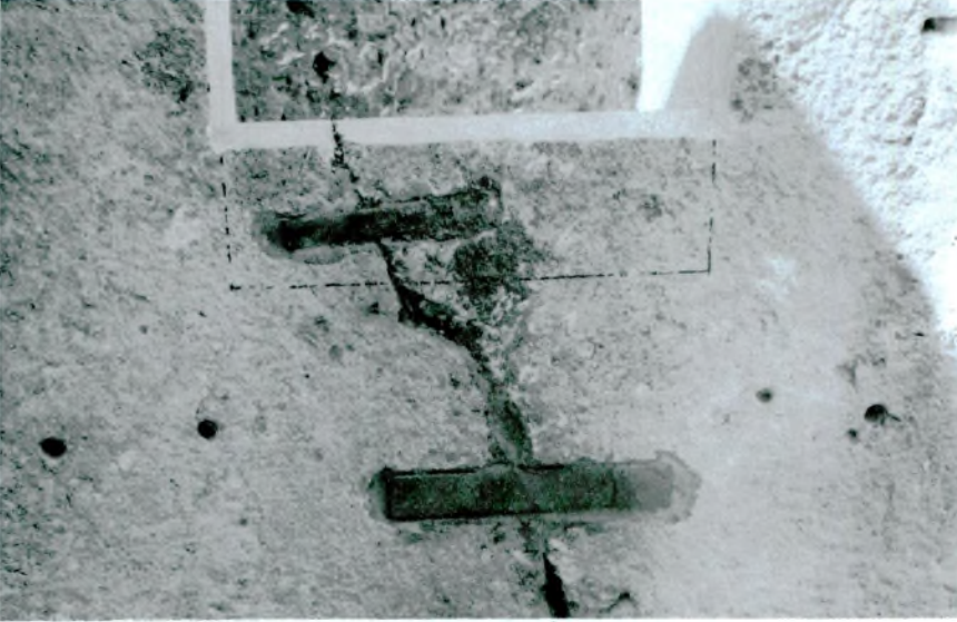
Res. 38 — Birleřtirilen paraların kenet kullanarak glendirilmesi.
