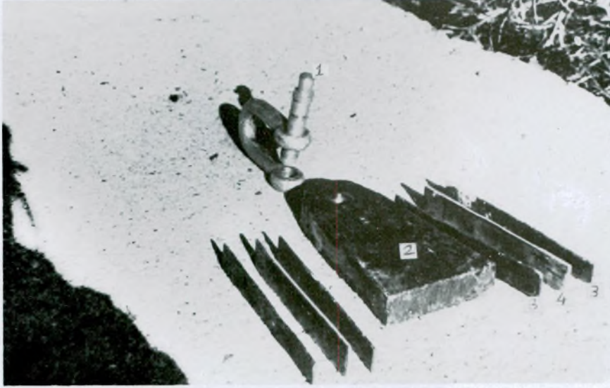
Res. 13 — Antik kaldıraç deliklerinden kaldırma yapmak için gerekli olan malzeme: 1 — Zincir kilidi, 2 — Kurt ağzı, 3 — Kurşun lamalar, 4 — Çelik lama.
