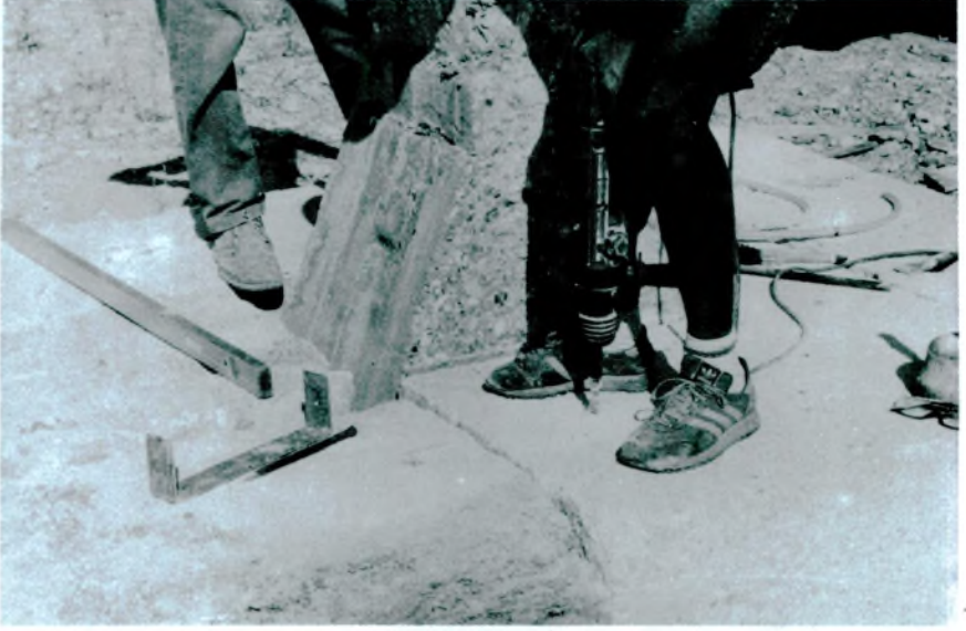
Res. 39a — Kenet yuvalarının açılması.
