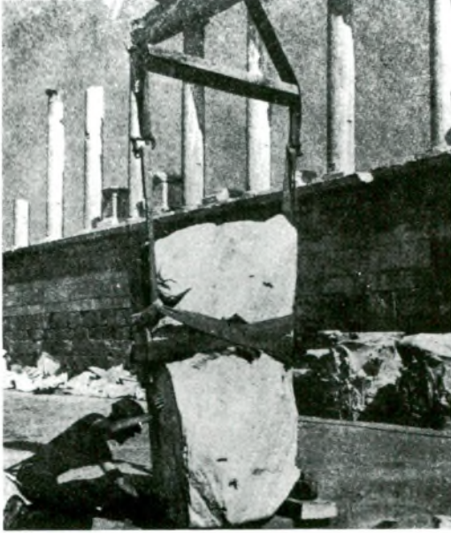
Res. 9 — Sentetik kayış kullanılarak kaldırılan mimari eleman (Radı'tan).
