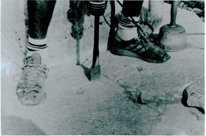
Res. 39b — Kenet yuvasının kenarlarının sınırlandırılması.
