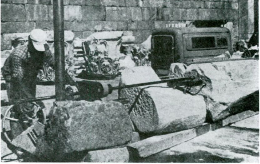
Res. 31 — Hareketli ve ayarlanabilen matkapla delik delme (Radt'tan).
