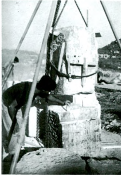
Res. 24 — Metal çubuk kullanarak iki parçanın birleştirilmesi.
