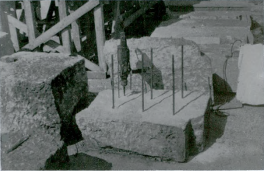
Res. 34 — Yerleştirilen çubuklarla deliklerin doğrultularının belirlenmesi.
