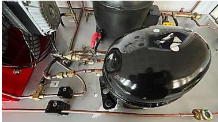
Şekil 5. Deney düzenegine ait görünüm
