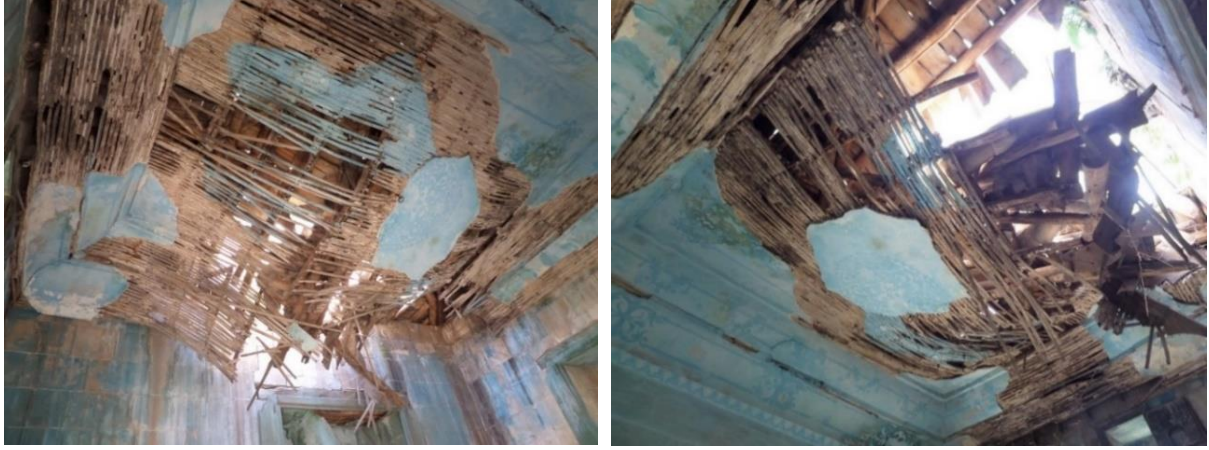
Şekil 4. a, b. Bir kısmı yıkılan bağdadi tekniğinde dörtgen tekne tavanlar - Karaçizmeler Evi [17]
