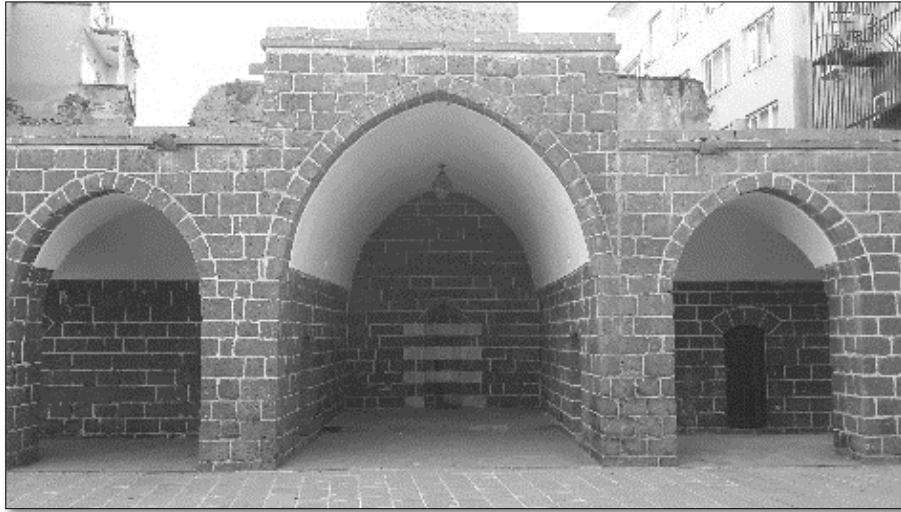
Şekil 8. Kuzey Cephesinden Görünüş
