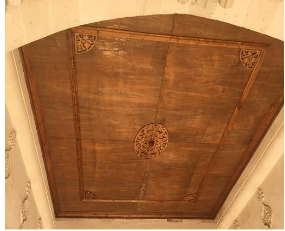
b. Yüzeyi kaplanmış ahşap düz tavan
