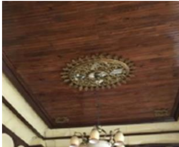
Şekil 6. Yalın bırakılmış ahşap tekne tavanlar
