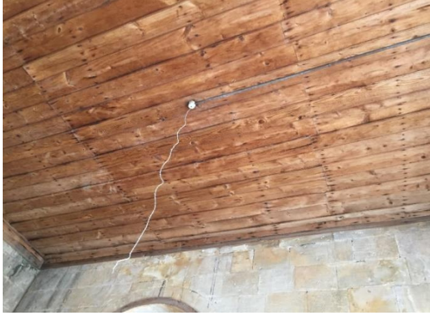
a. Yalın bırakılmış ahşap düz tavan
