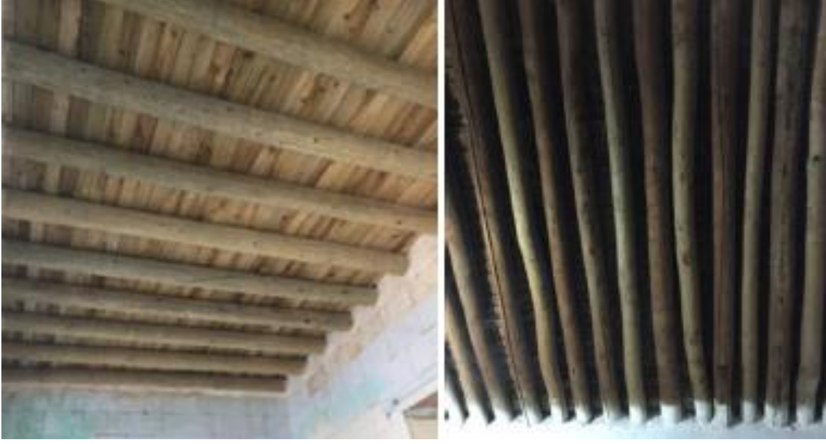
Şekil 1. Ahşap kirişli tavanlar
