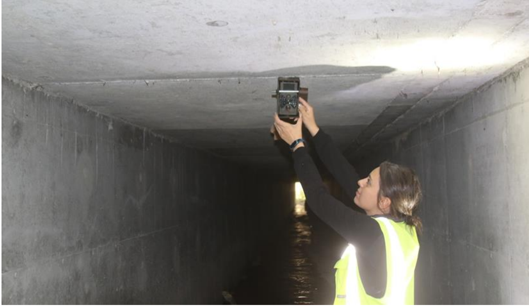
Şekil 2. Fotokapanın drenaj yapısının tavanına monte edilmesi
