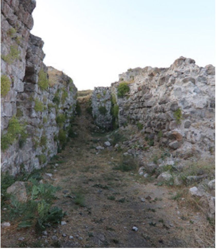
Görsel 7. Bitlis Sinan Bey (Kale) Hamamı Su Deposu
