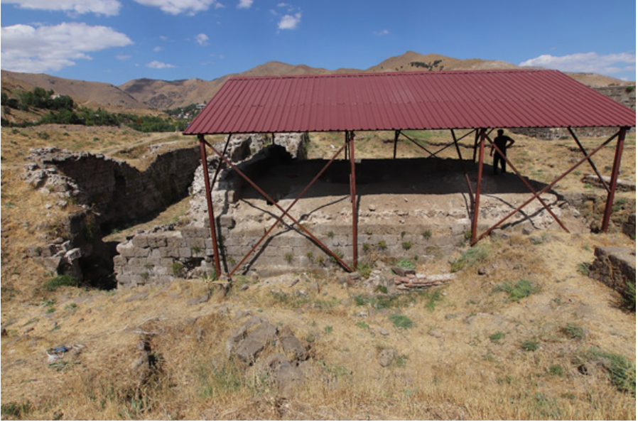
Görsel 19. Bitlis Sinan Bey (Kale) Hamamı Güney Cephesi
