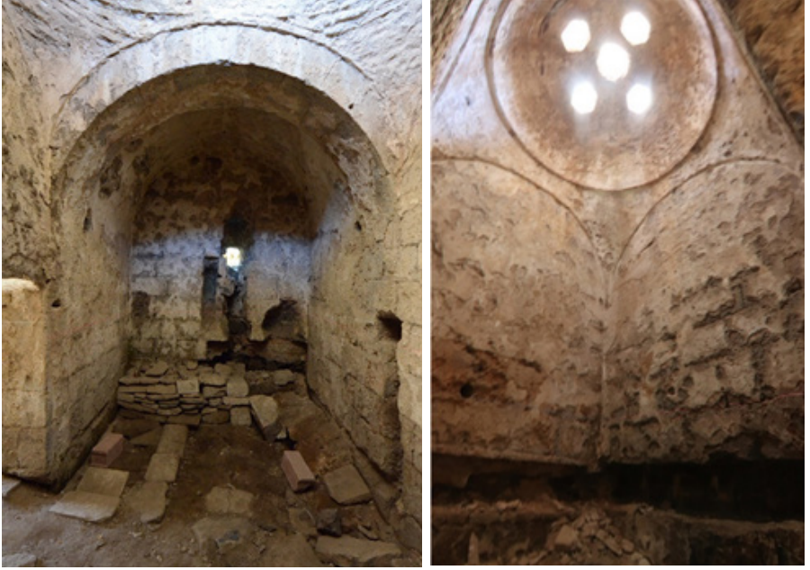
Görsel 9. Bitlis Sinan Bey (Kale) Hamamı Soyunmalık ve Sıcaklık Mekânı
