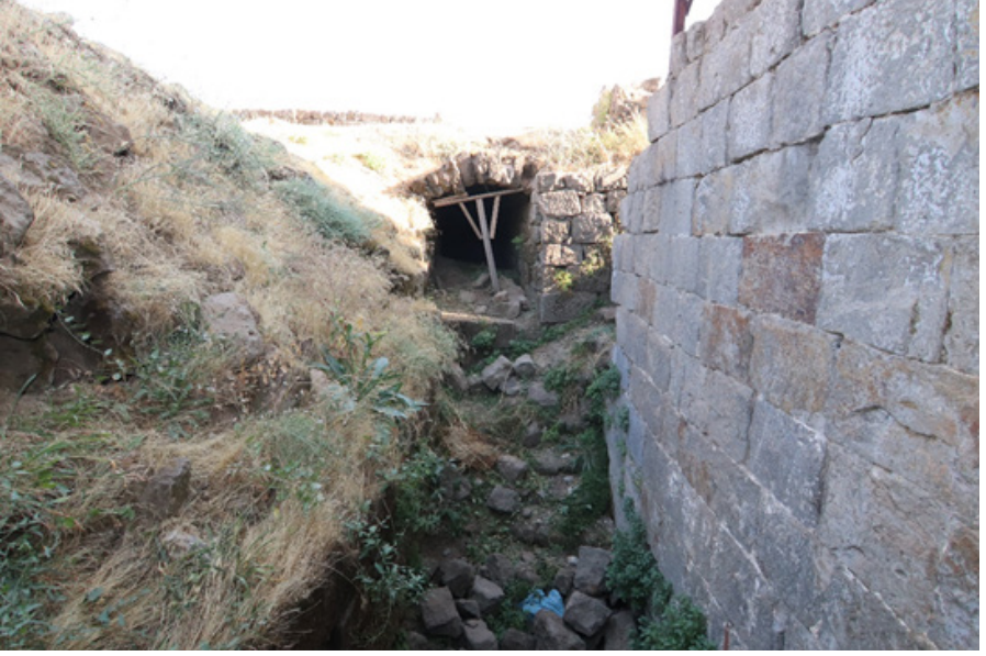
Görsel 12. Bitlis Sinan Bey (Kale) Hamamı Doğu Cephesi ve Mahzen
