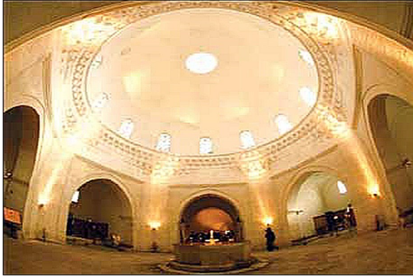
Şekil 4b: Altıgen orta avlu üzerinde geniş kubbe olup statik olarak kasnak görevi yapan çember aynı zamanda seslerin toplandığı noktaya denk getirilmiştir 6 .
