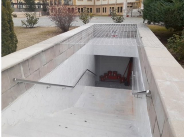
Görsel 13. Bahçe içerisinde yer altı tuvaletleri (ÇMM, 2021)
