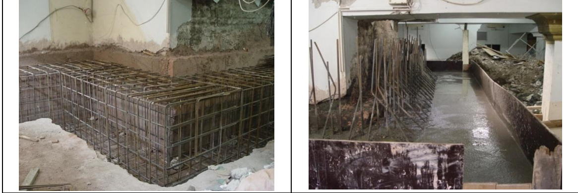
Şekil 10. Kâgir temel sistemine yapılan takviye (Hassa Mimarlık, 2004)
