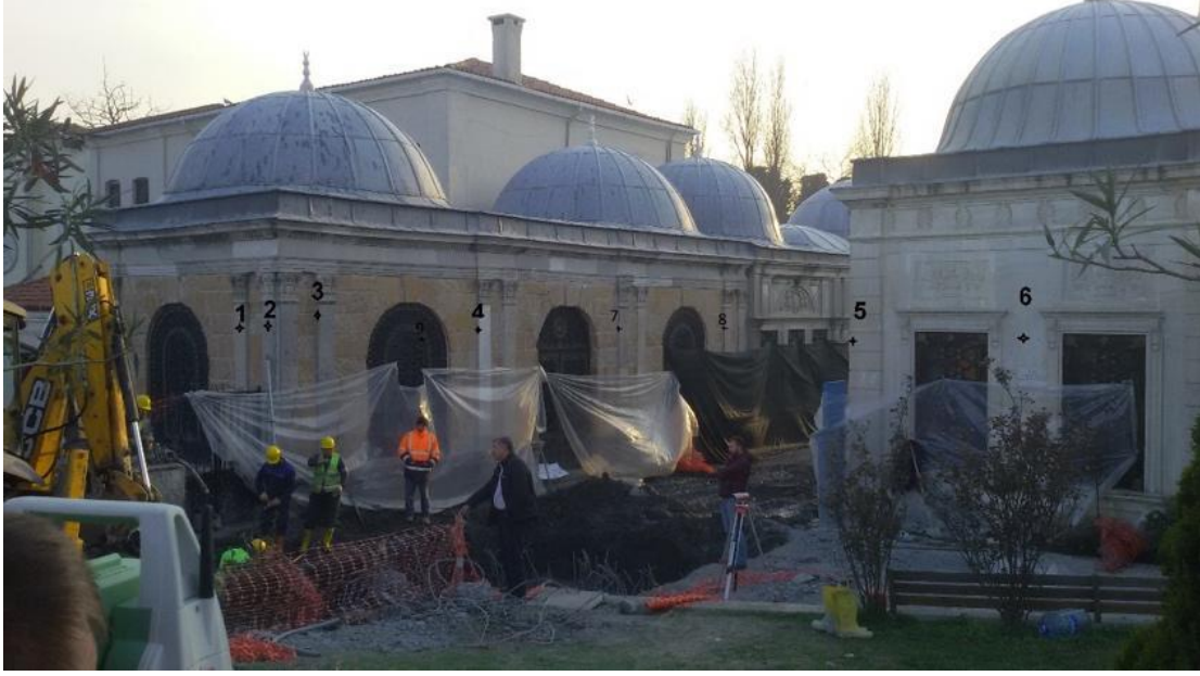
Şekil 5. Terfi Merkezi inşaatı için açılan temel çukuru (Hassa Mimarlık, 2014)
