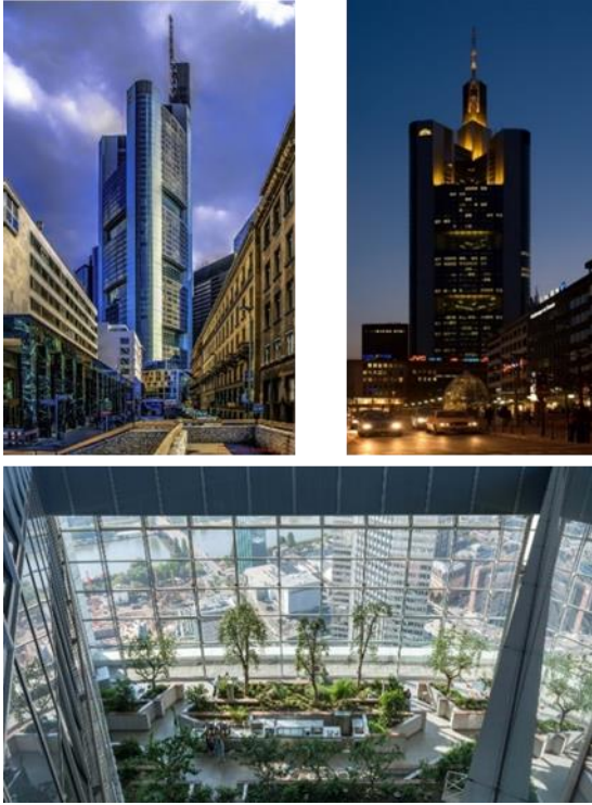
Şekil 4. Commerzbank Binası GörSELLERİ (Url-3)
