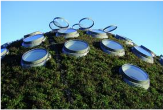
Şekil 6. Acros Fukuoka Vakfı Binası'na ait görseller (Url-5).
