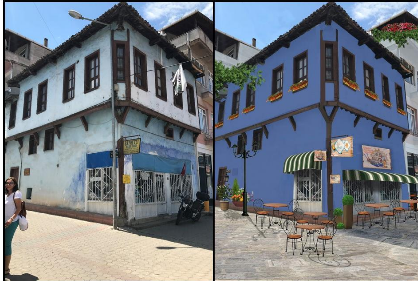
Şekil 9. Osmaneli'ndeki yapı cephelerine ilişkin ikinci görselleştirme çalışması
