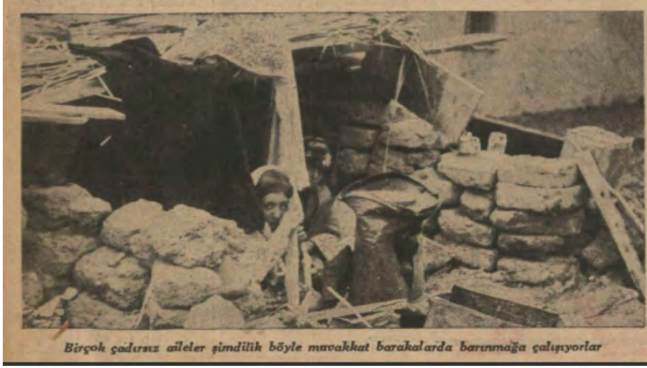
Görsel 2. Çadırı olmayan vatandaşlar derme çatma barakalarda barınmaya çalışıyorlar (Tan, 4 Ocak 1940).
