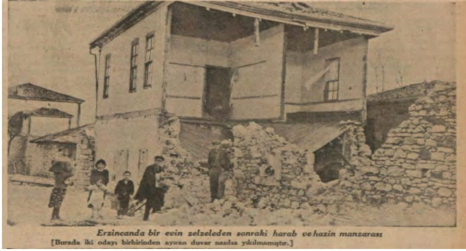
Görsel 4. Erzincan'da zarar görmüş bir ev ve depremzede vatandaşlar (Cumhuriyet, 4 Ocak 1940).
