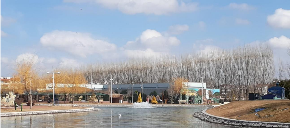
Şekil 1. Tropik Merkez Genel Görünüm
