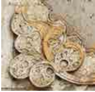
Görsel 25 Sol taraftaki rûmî kabartmanın restorasyon sonrası mevcut görü- nümü. Fotoğraf: Ümmügülsüm Çilek, 2018.
