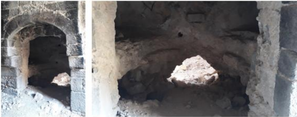
Şekil 10 - Niğde Yeşilburç Köyü Hamamı külhanı. Külhan ağzındaki duvarın yıkıldığı, kazanın çıkarılmış olduğu ve depodan sıcak suyun çıkışını sağlayan künk görünmekte (yazarın arşivi, 2020)
