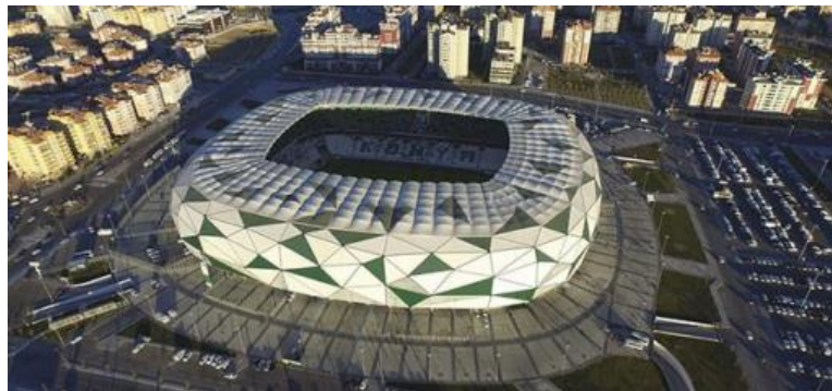
Şekil 10. Konya Büyükşehir Belediye Stadyumu ve yakın çevresinden görünüm [6]
