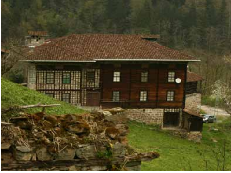
G. 9: Kesme taş duvar üstü ahşap dolma tekniği ve göz dolma tekniği, Rize (Kaynak: Selim İhtiyar Arşivi)
