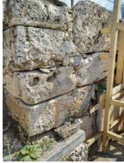
G. 12a ve G. 12b: Yapı malzemesindeki oyuklanma, çatlak ve kayıplar ile yapılan müdahaleler (Acun Özgünler, 2017).
