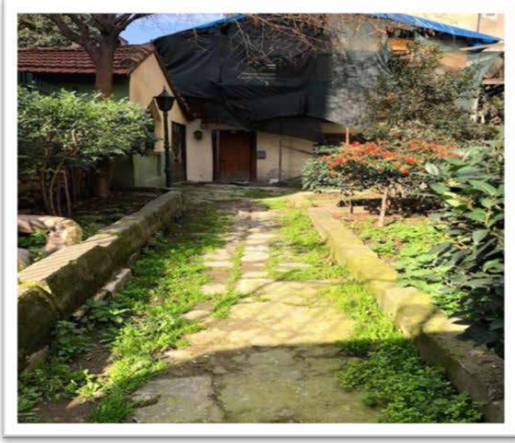
G. 14: Hüsrev Paşa Türbesi'ndeki Ahşap Yapı (E. İğüs, 2018)
