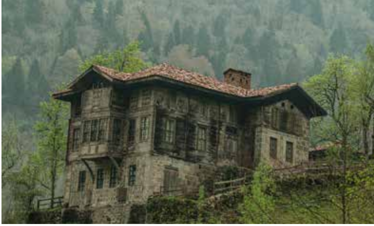
G. 11: Yığma taş duvar üstünde ahşap çatma sistemde göz dolma tekniği ve ahşap dolma tekniği, Rize (Kaynak: Selim İhtiyar Arşivi)
