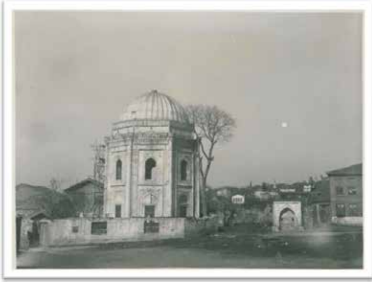
G. 25: Hüseyin Paşa Türbesinin 1950 Yıllardaki Restorasyonu (Salt, TASDOC0176009)
