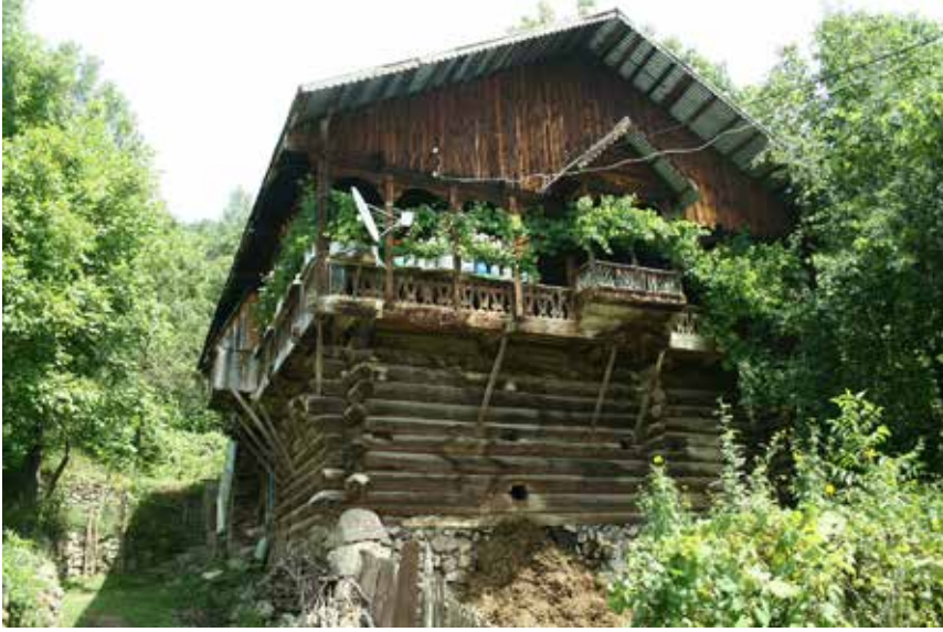
G. 8: Yığma taş duvar üstü ahşap yığma tekniği ve üzerinde ahşap çatma tekniği, Artvin, Şavşat (Kaynak: Selim İhtiyar Arşivi)
