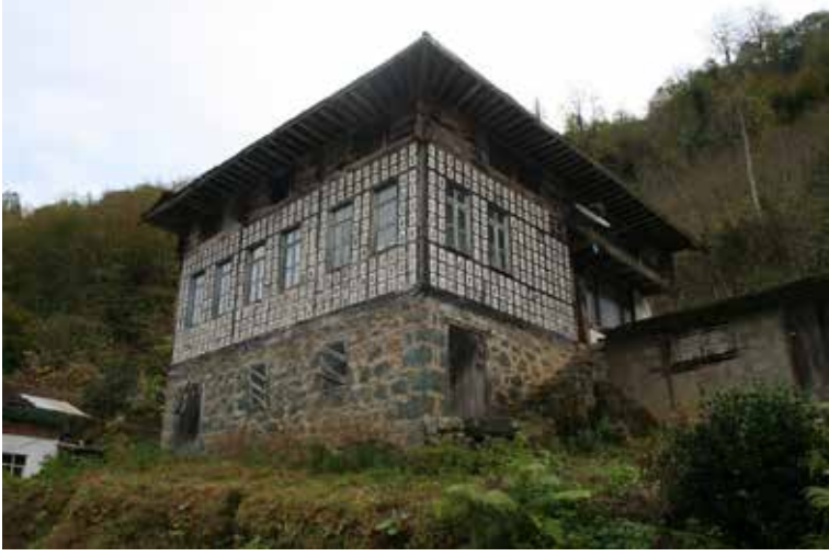
G. 12: Ahşap çatma sistemde göz dolma tekniği (Kaynak: Kültür ve Turizm Bakanlığı Arşivi) https://www.ktb.gov.tr/yazdir?8E12B514BE83CADCEAF90FCBE3F42130
