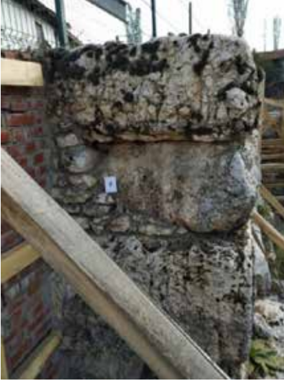
G. 12a ve G. 12b: Yapı malzemesindeki oyuklanma, çatlak ve kayıplar ile yapılan müdahaleler (Acun Özgünler, 2017).
