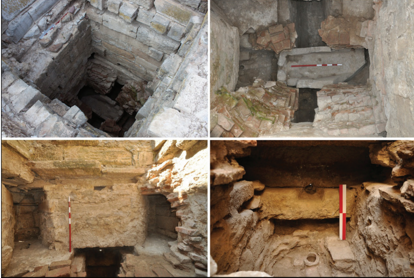
Resim 10: Namazgâhlı Çeşme, içerisinden görünüm.
