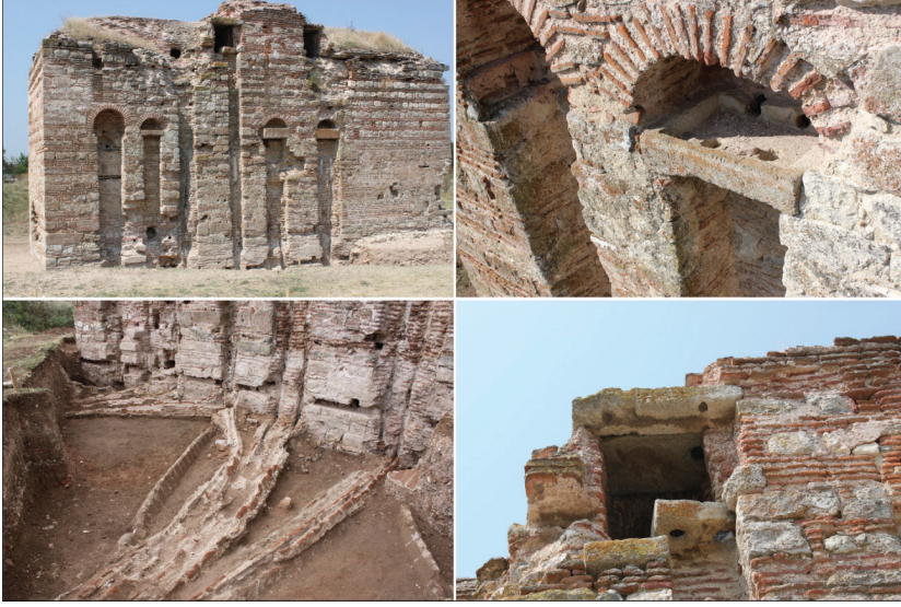
Resim 6: Maksem, kuzeydoğu cephesi ve su sistemleri detayları.
