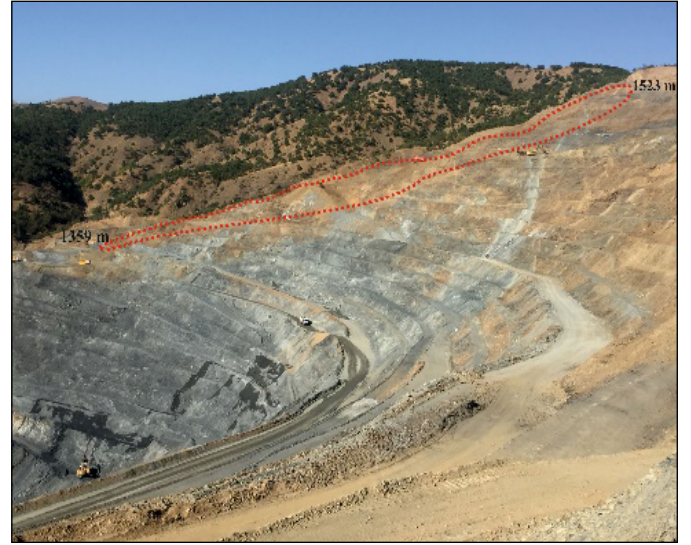
Şekil 8. Taç noktası 1523 m topuk noktası 1359 m olan şev duraysızlığı (şist)
