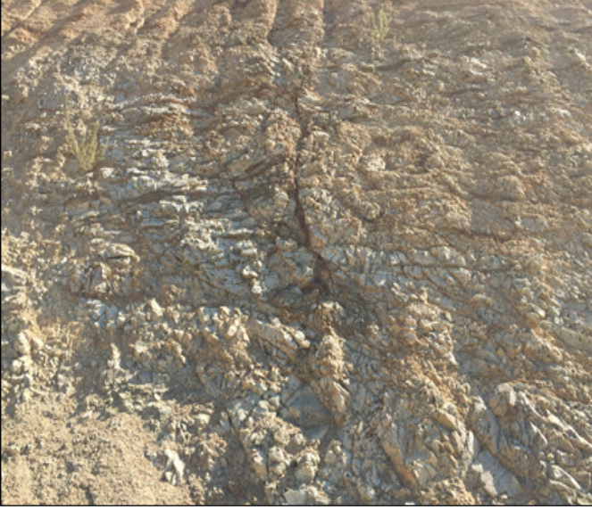
Şekil 2. Sürsüzlikler tarafından parçalanmış şev malzemesi (şist)
