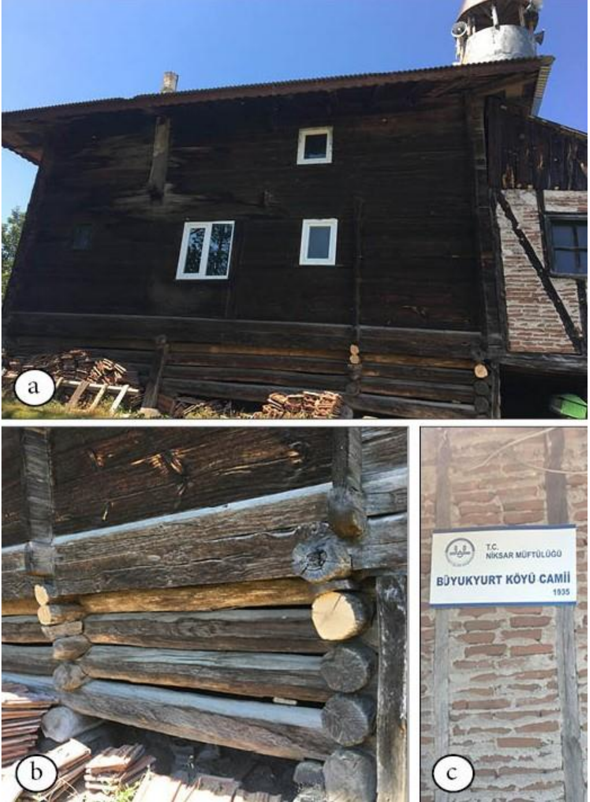
Şekil 4. a) Büyükyurt Camisi, b)Örnek alınan taban kısmındaki ahşaplar, c) Caminin tabelası
