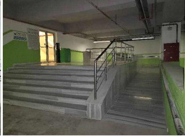
Şekil 16. 4. Bodrum Katta Bulunan Rampa.
