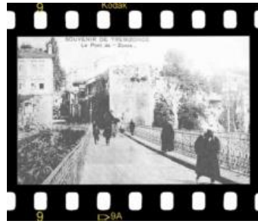
Fig. 6. Zağnos Bridge (1930's) (Kardeş, 2006)
