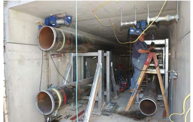
Şekil 3. United States Capitol Visitor Center Utility Tunnel iç görünüşü (Capitol Visitor Center Project Office, 2005).
