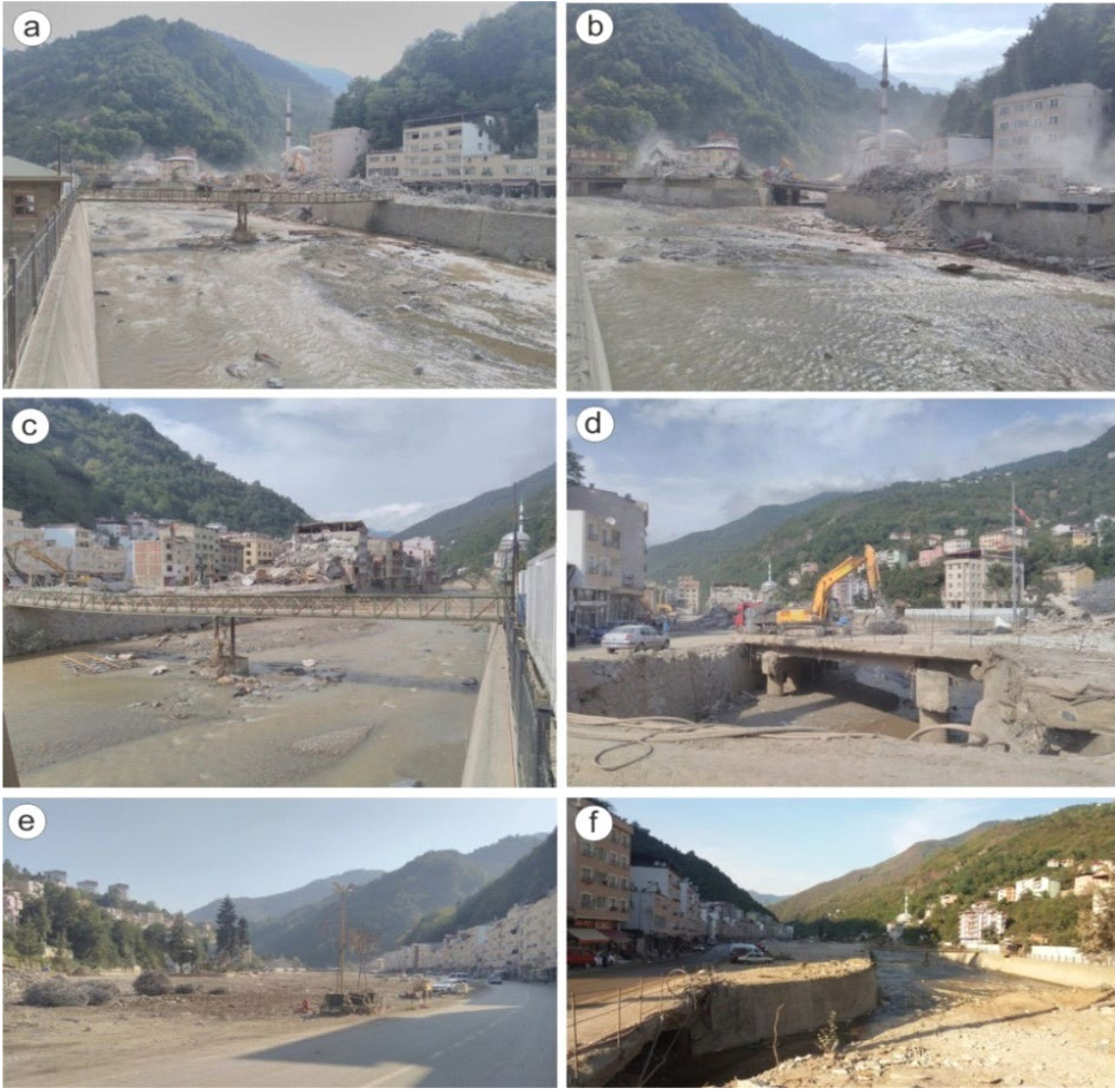
Şekil 18. Dereli’de kentsel dönüşüm projesi kapsamında yıkım işlemlerinden görüntüler (a ve b: Aksu üzerinden Dereli Deresi tarafına, c: Aksu üzerinden aşağıya, d: Dereli Deresi üzerindeki üst köprüden aşağıya, köprüler yıkılmadan önce, e: yıkım işlemleri tamamlandıktan sonra ilçenin alt tarafındaki Aksu köprüsünden yukarıya, f: Yıkım işlemleri tamamlandıktan sonra Aksu üzerinden aşağıya bakış, fotoğraflar A.Apaydın, a,b,c,d 13 Eylül 2020, e,f 18 Ekim 2020).
