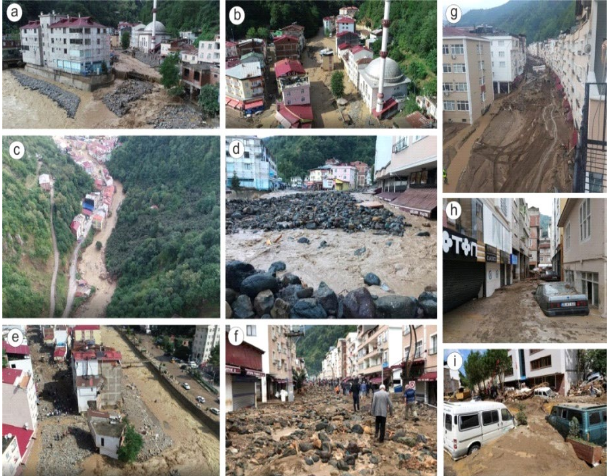
Şekil 8. Dereli’de 22 Ağustos, 2020 tarihli taşkın sonrası görüntüler (a: Malzeme ile tıkanan köprülere Aksu Çayı üzerinden bakış, b: Köprülerin arkasında çökelen malzeme, c: İlçenin Dereli havzasına doğru uzanımı ve vadi içinde çökelen malzeme, d, e, f: Çamur, kum, çakıl ve iri blok boyutlarındaki sediment malzemenin ilçe merkezindeki caddelerde çökerek dükkanların giriş kat tavanına kadar yükselmesi, g: ana caddedeki malzeme yığına aşağı taraftan bakış, h, i: malzeme içine gömülmüş araçlar, foto a,b,c,d,e DSİ 226. Şube, f: gundemebakis.com, g: egedesonsoz.com, h,i: ensonhaber.com).
