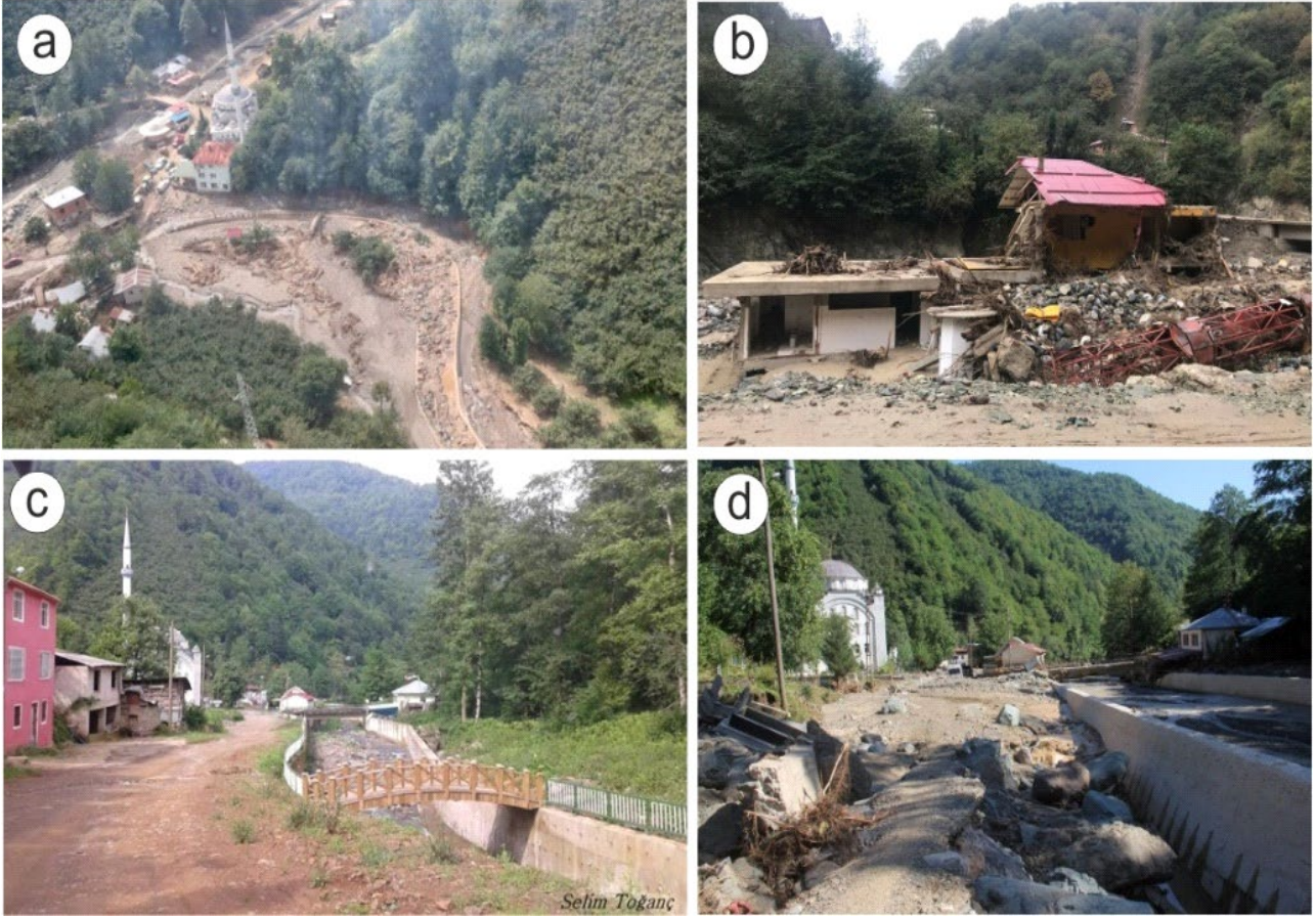
Şekil 9. 22 Ağustos, 2020 tarihli taşkında Dereli havzasında bulunan Akkaya köyü merkezinde (Dereli Deresi'nin Akkaya ve Büyük Dere olarak iki kola ayrıldığı yerde) hasardan görüntüler (c: eski hali, d: aynı yerin taşkından sonraki hali, fotoğraflar www.akkayakoyu.org sitesinden).
