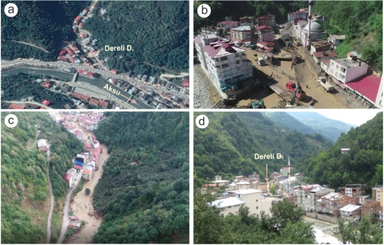
Şekil 15. Dereli Deresi yatağının binalarla işgalinden görüntüler (a: Ağustos'2019 tarihli Google Earth görüntüsü, b: Taşkından üç gün sonra temizleme ve binalarda yıkım başladığında mansaptan görünüm, c: Taşkının ertesi günü akış yukarıdan görünüm, d: Vadi girişinin Temmuz'2012'de çekilen fotoğrafta karşıdan görünümü, foto b ve c DSİ 226. Şube, d A.Apaydın).
