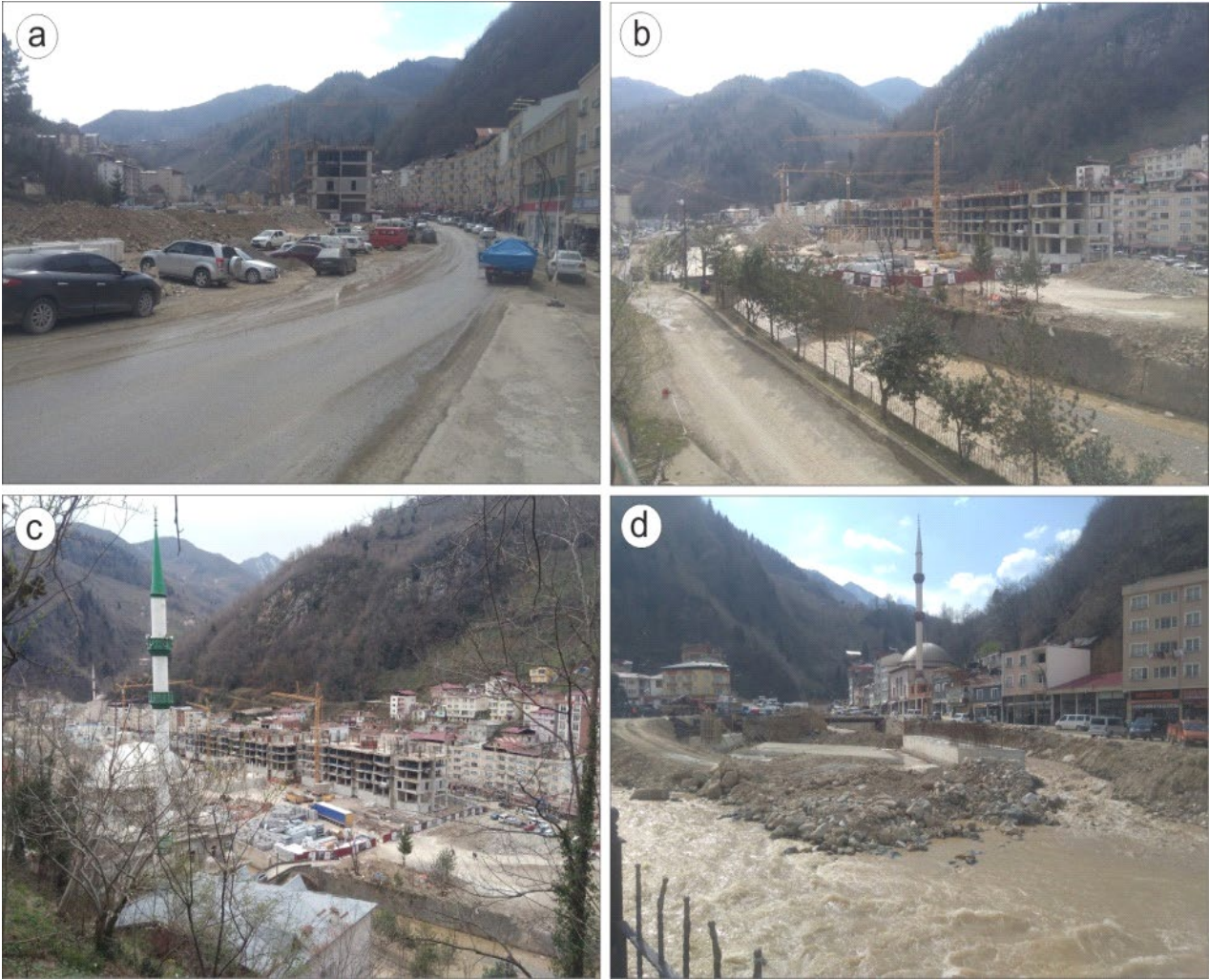
Şekil 19. Dereli'nin yeniden inşasından görüntüler (a, b, c: Proje kapsamında yıkılan yapıların yerine inşa edilmeye başlanan yapılarla değişik cephelerden bakış, d: Dereli-Şebinkarahisar karayolu üzerindeki eski köprünün yerine inşa edilmekte olan yeni köprünün ayakları, fotoğraflar A.Apaydın, 16 Mart 2021)
