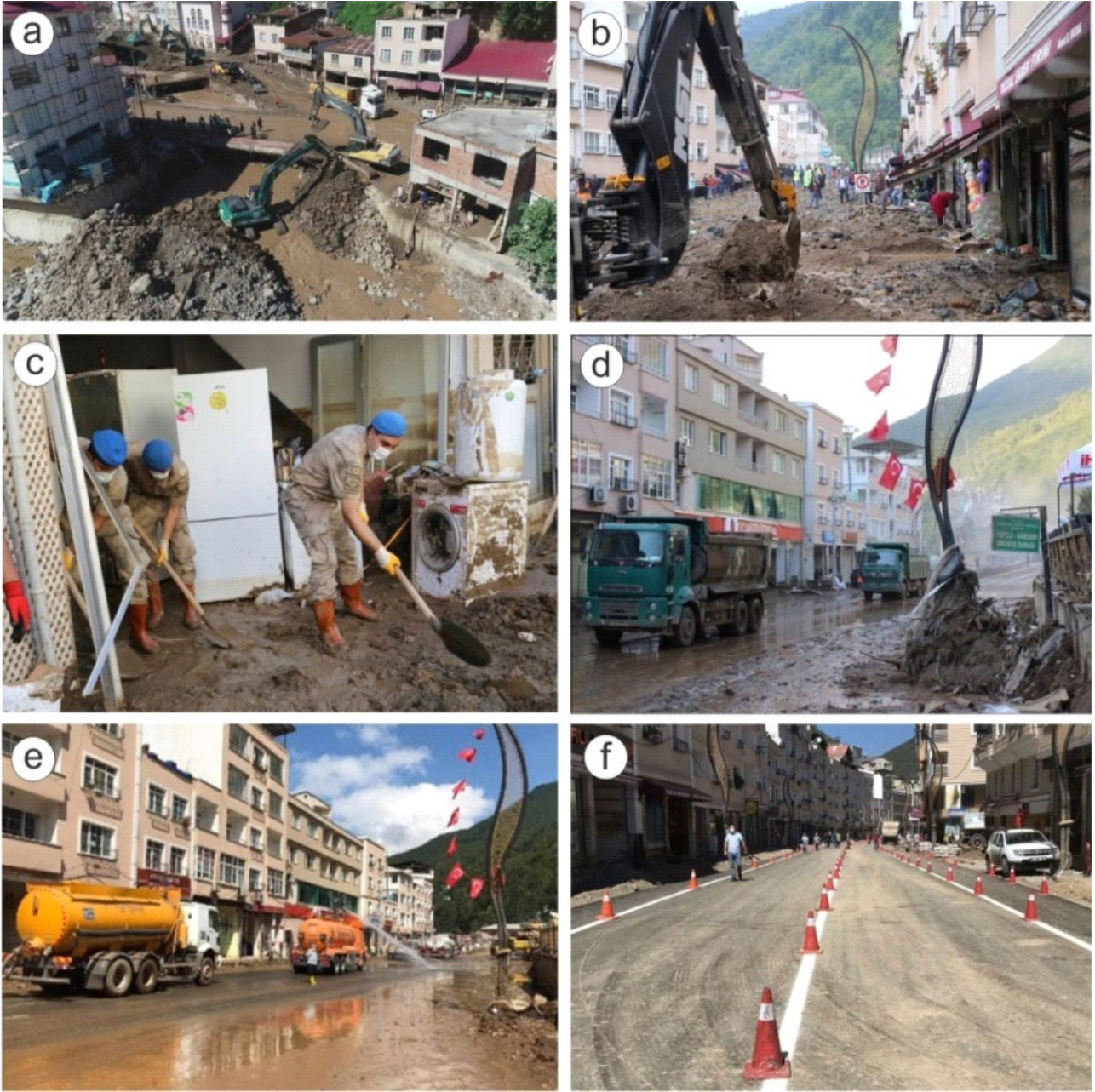
Şekil 10. Dereli’de sediment malzemenin temizlenmesi ve ana caddede yeniden asfaltlama çalışmalarından görüntüler (foto a: DSİ 226. Şube, b,c,d,e,f: sanalbasin.com).
