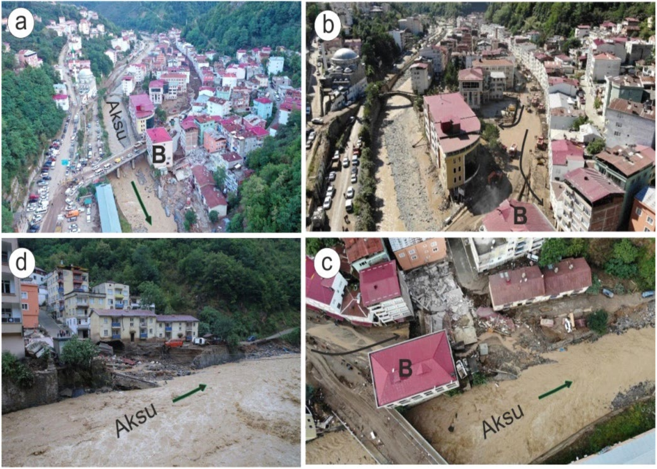
Şekil 13. Dereli meydanında ve aşağısında sediment birikimi ve su akışını etkileyen unsurlardan, arkasındaki meydana göre kötü yüksek olan Aksu köprüsüne bitişik Halk Eğitim Binasının çeşitli açılardan görüntüleri ve akışın yönlendirilmesi (a, b, c) ve binanın solundaki boşluktan akan suyun etkisiyle yıkılan ve hasar gören binalar (d) (foto a: ihh.org.tr , b: twitter.com , c: hicrethaber.com , d: dogruhaber.com ).
