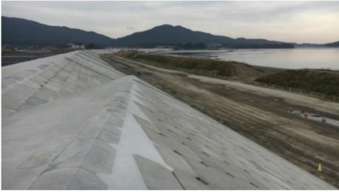
Şekil 4. Rikuzentakata Kıyı Tahkimatı (Tarih: Ekim, 2016)
