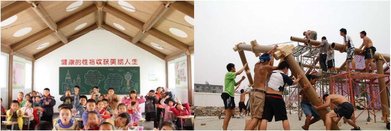
Şekil 21. Hualin İlköğretim Okulu geçici sınıflar ve yerel malzeme kâğıt tüp kullanımı
