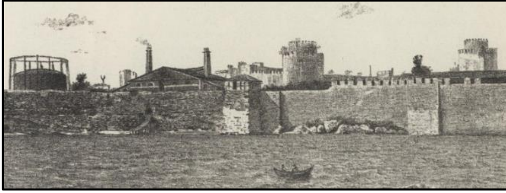
Şekil 1. Rumeli Demiryolu Hattı - Yedikule İstasyonu (Çobanoğlu & Yılmaz,2017)
