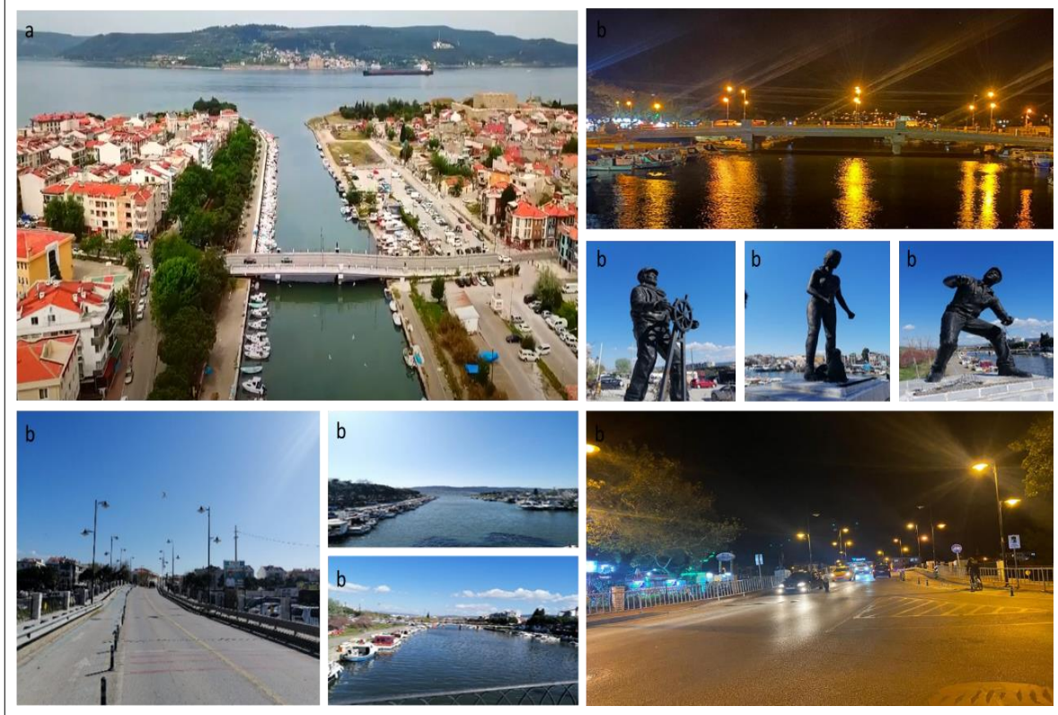
Şekil 6. İnönü Köprüsü genel profili ve köprüden kesitler (a: Öztürk, 2020; b: Orijinal, 2021).
