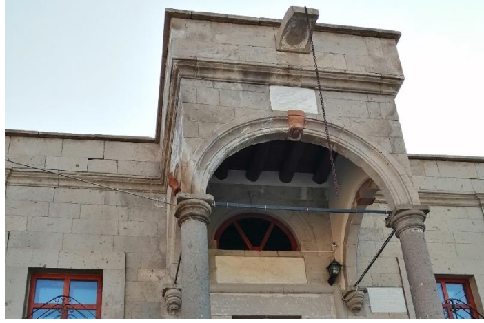
Şekil 17. Giriş revağı yakın görünüm
