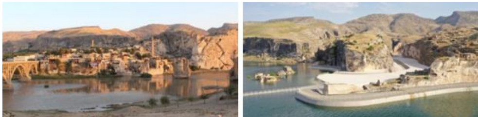
Şekil 2. Hasankeyf önceki durumu ve günümüzdeki durumu (Hasan Söyletmez Arşivi, 2021)
