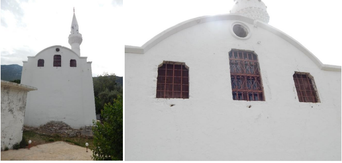
Görsel 10-11: Yapının Batı Cephesi ve Pencere Detayı
