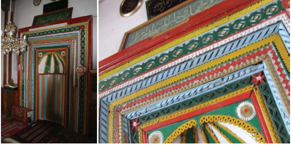
Fot. 27-28: Beyşehir Bayağşar Hızır Ali Paşa Camii mihrabının önceki durumu (Konya Vakıflar Bölge Müdürlüğü Arşivi, KVBMA)
