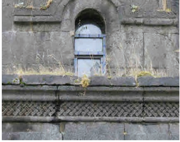
Fot. 30: Kars, Surp Arak'elots Kilisesi (10-11. yy.), kasnak kemerlerinin oturduğu üzengi taşları. (Sağır, 2001, 95.)
