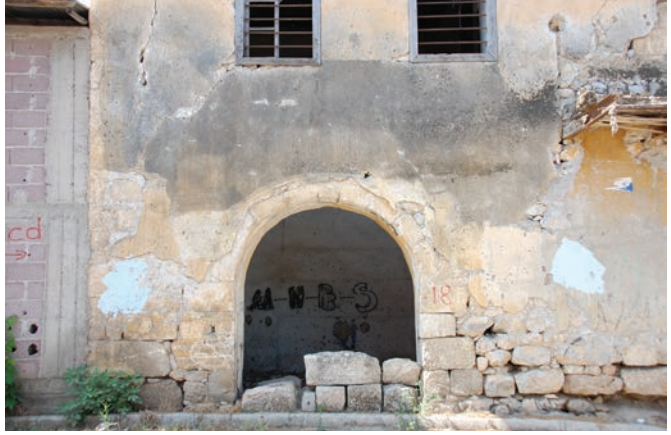
Fot. 2: Kuzeydoğu Köşedeki Mekana Giriş
