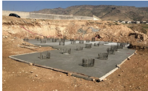
Fot. 15 (a), (b): İstinad duvarları ve kazık uygulamaları. (Er-Bu İnşaat, 2019.)
