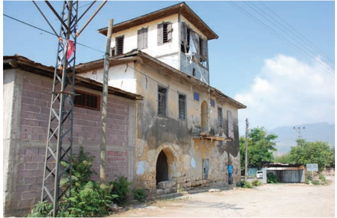
Fot. 3: Kuzey Cephe
