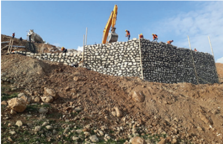
Fot. 15 (a), (b): İstinad duvarları ve kazık uygulamaları. (Er-Bu İnşaat, 2019.)
