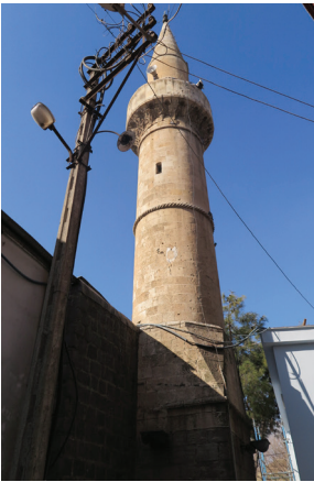
Fot. 21: Siverek Sulu Cami Minare
