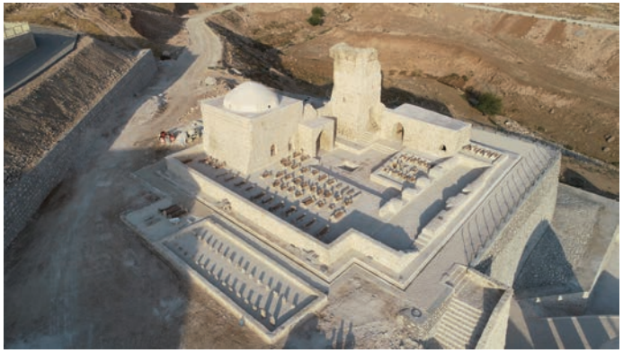
Fot. 17. (a), (b): Taşıma sonrası koruma-onarım çalışmalarından görünüm. (Er-Bu İnşaat, 2019.)
