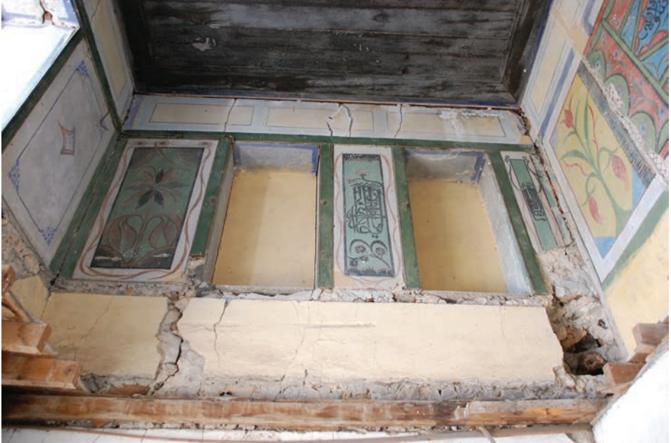
Fot. 8: Birinci Kat Kuzeydoğu Köşedeki Mekanın Doğu Duvarı Kalemîşi Süslemeler
