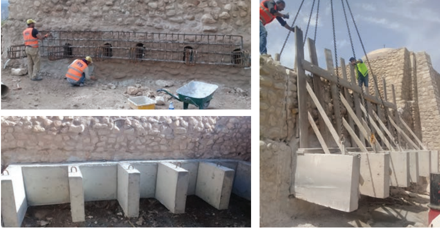
Fot. 10 (a), (b), (c): Duvarlarda betonarme kiriş sisteminin oluşturulması, kalıntının yerinde alınması. (Er-Bu İnşaat, 2019.)
