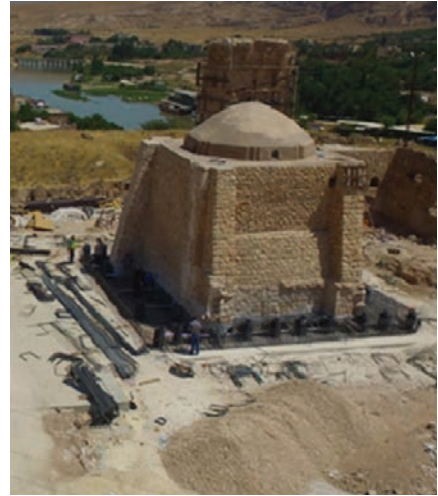
Fot. 11 (a), (b), (c): Kaldırma/taşıma plağının demir donatısının oluşturulması. (Er-Bu İnşaat, 2019.)
