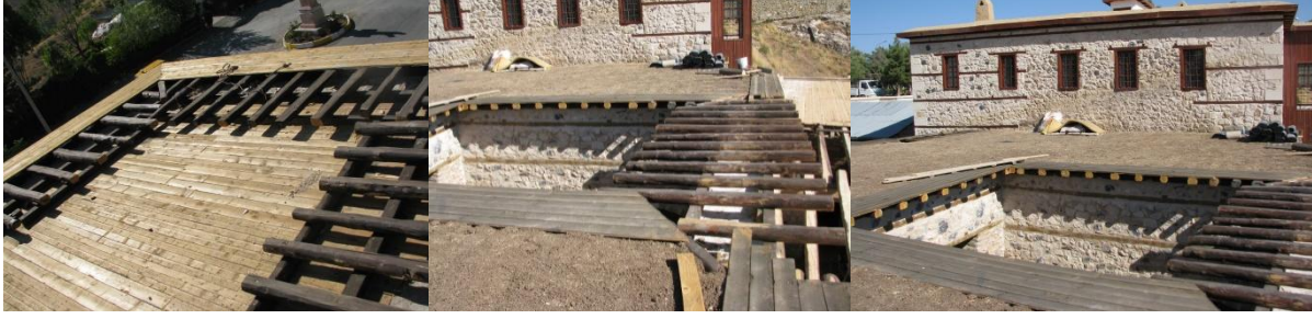
Şek. 77-79: Sağır Müftü Konağı Düz Dam Onarım Görünüşleri (Ş. Öztürk 2009)
