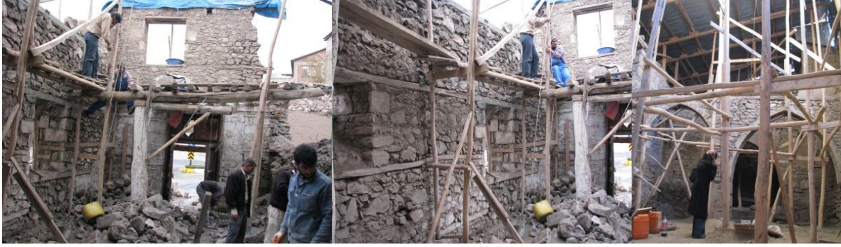
Şek. 59-61: Sağır Müftü Konağı İç Mekân Onarım Görünüşleri (Ş. Öztürk 2009)
