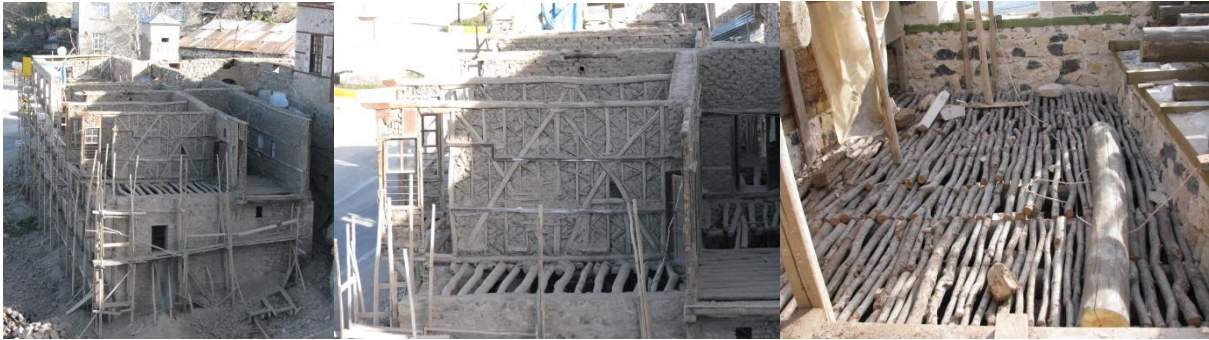
Şek. 62-64: Sağır Müftü Konağı Onarım Görünüşleri (Ş. Öztürk 2009)
