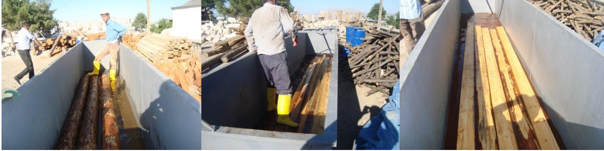
Şek. 80-82: Sağır Müftü Konağı Ahşap Daldırma-Dinlendirme Emrey Görünüşleri (Ş. Öztürk 2008)
