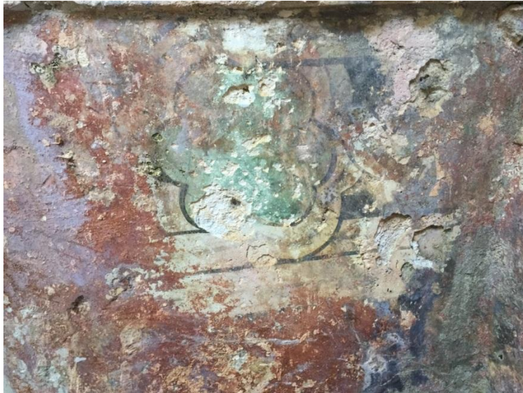
Res. 4: Mamure Hamamı Sıcaklık Bölümünde Yer Alan Kalemîşi Süslemelerinden Bir Örnek
