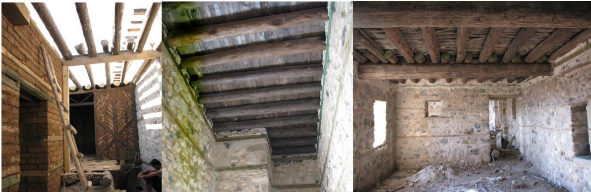
Şek. 83-85: Sağır Müftü Konağı İç Mekân Onarım Görünüşleri (Ş. Öztürk 2009)
