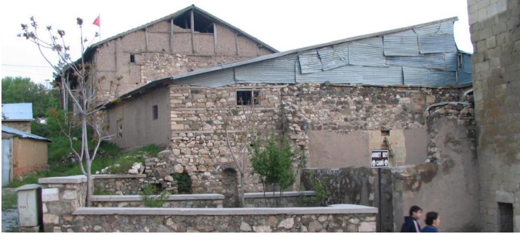
Şek. 11: Sağır Müftü Konağı Kuzeydoğu Genel Görünüşü (Ş. Öztürk 2008)
