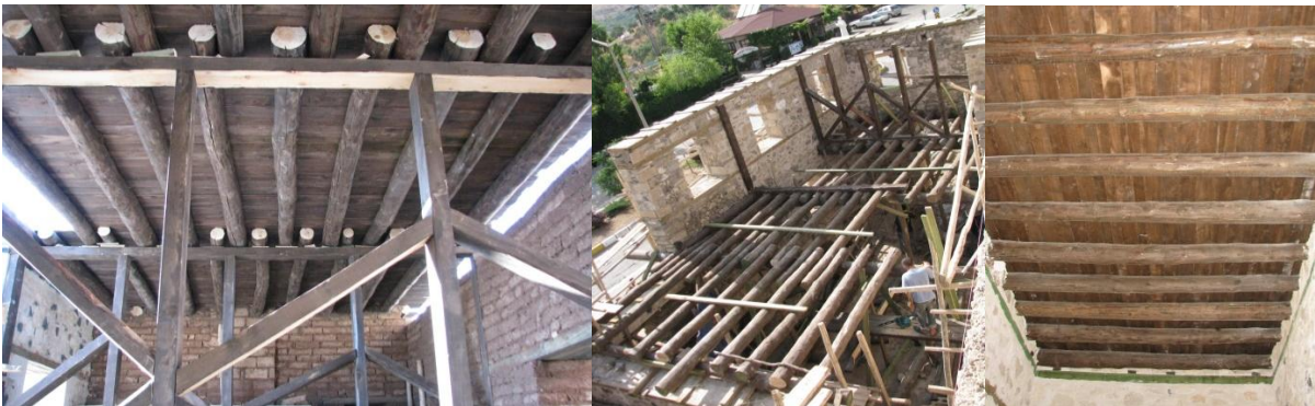
Şek. 74-76: Sağır Müftü Konağı Onarım Görünüşleri (Ş. Öztürk 2009)
