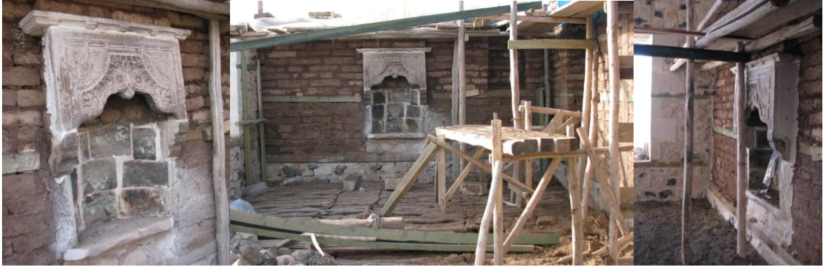
Şek. 68-70: Sağır Müftü Konağı Ocak Onarım Görünüşleri (Ş. Öztürk 2009)
