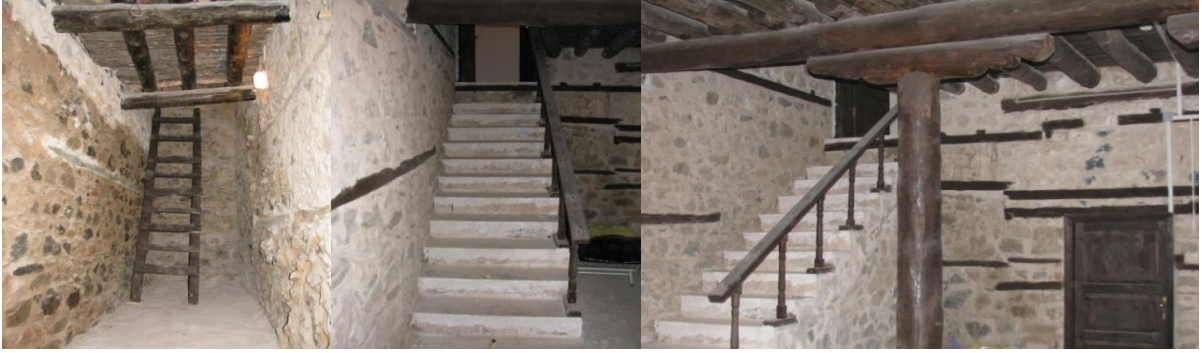
Şek. 89-91: Sağır Müftü Konağı Onarım Sonrası İç Mekân Merdiven Görünüşleri (Ş. Öztürk 2009)
