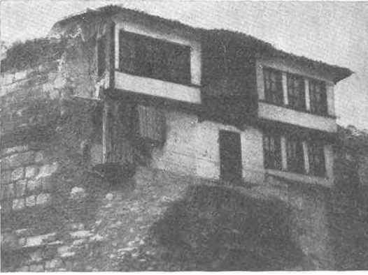
Res. 40 — Kale eteklerine yerleştirilmiş bir ev.
