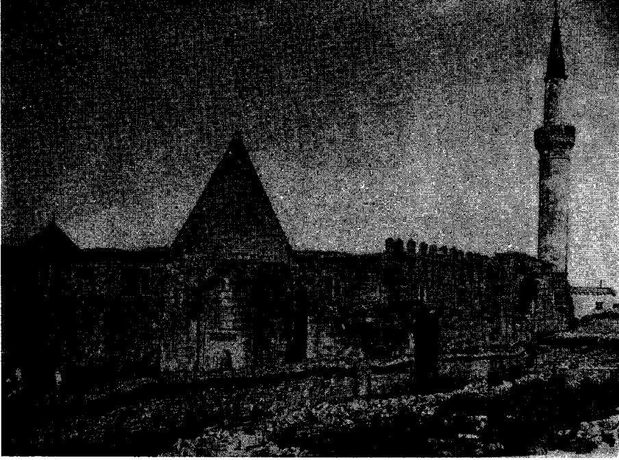
Res. 1 — Beyşehir Eşrefoğlu camii ve Türbesinin Genel görünüşü (1900 yılındaki durumu).
