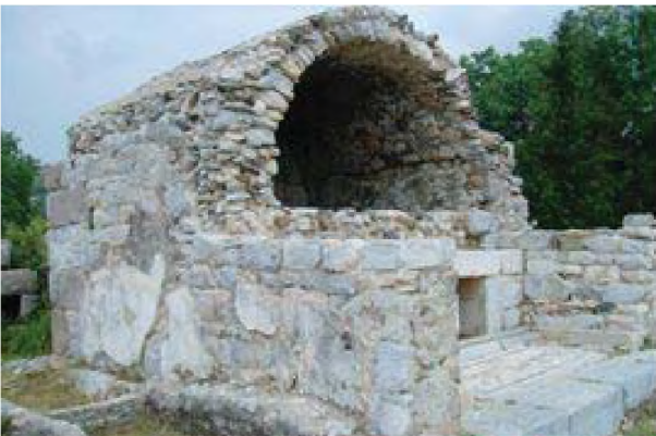
Resim 9. 3 No.lu mezar yapısının yan cephe görünüşü
