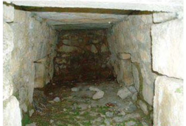
Resim 27: 10 No.lu mezar yapısının kriptaya iç görünüşü
