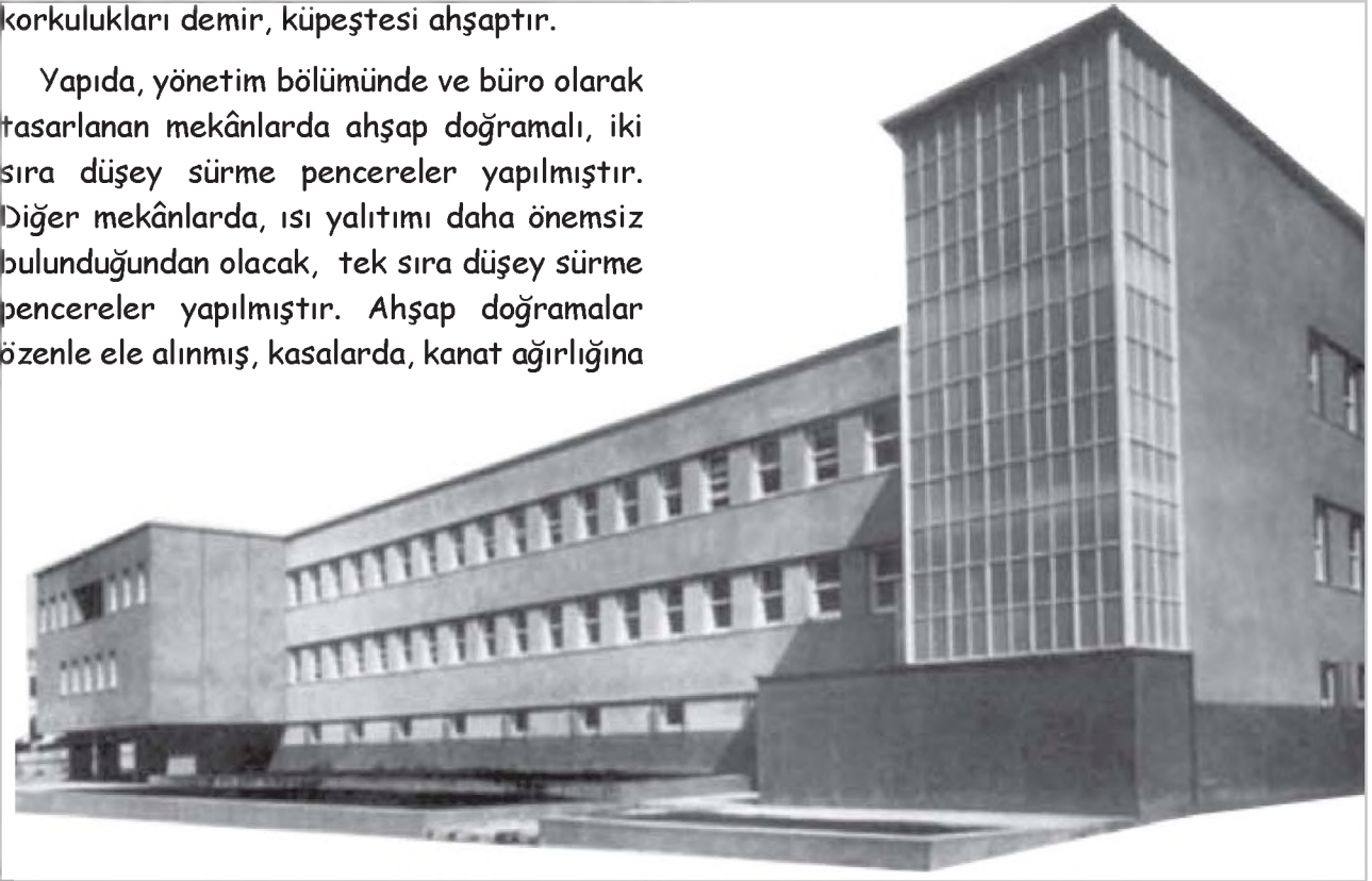
Resim 4: Yapının kuzeybatı görünüşü (2008) Kaynak: Özel Çekim
