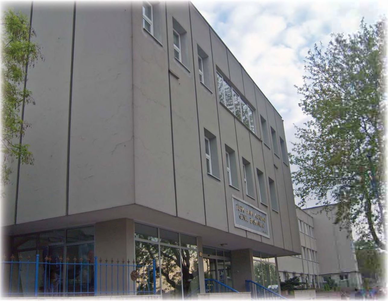
Resim 5: Yapının kuzeybatı görünüşü (2008) Kaynak: Özel Çekim
