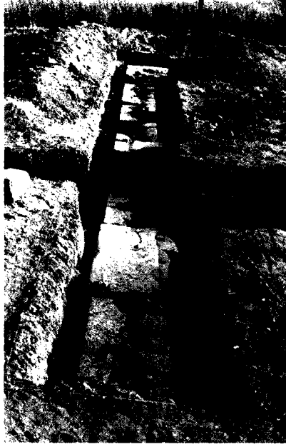
Resim: 13- Patara. Düzset-Yapısı temeli
