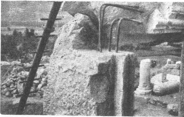
Res. 21—Dikey ve yatık kapı söveleri demir kenetlerle tutturulmuştur.
