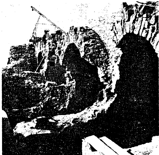
Abb. 19 Restaurierungsarbeiten am Trajaneum. Tonnengewölbe vom Schutt befreit.
