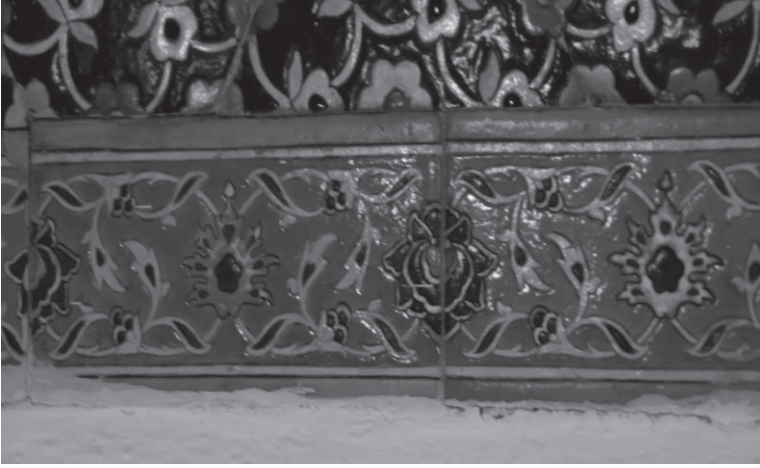
Fotoğraf 20: Bozüyük Kasım Paşa Camii iç mekan doğu cephe ortasındaki pencere alınliğı bordür
