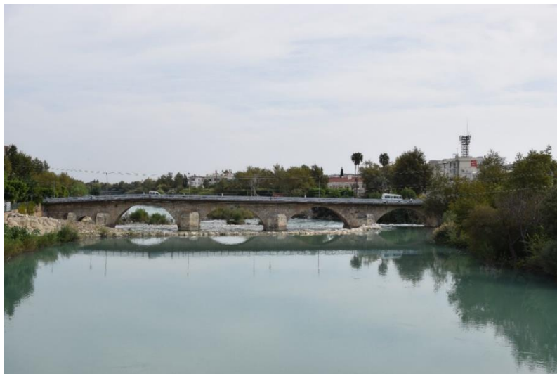
Resim 2. Silifke Taş Köprü
