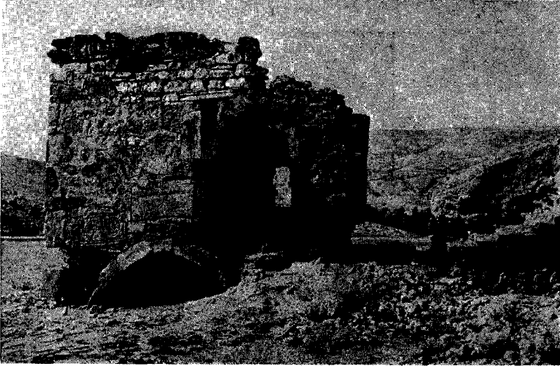
Res. 2 — Konya-Altınapa Kervansaray Mescit Binası.
