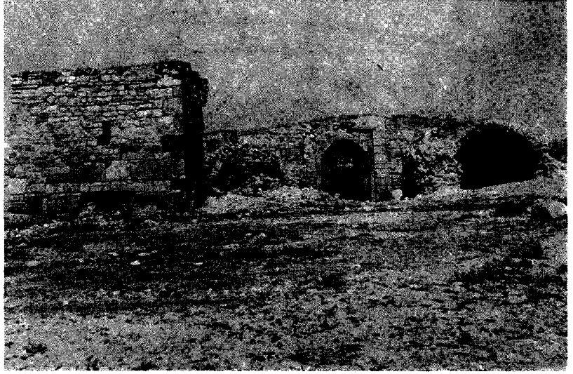
Res. 1 — Konya-Altınapa Kervansarayı giriş kısmı görünüşü.
