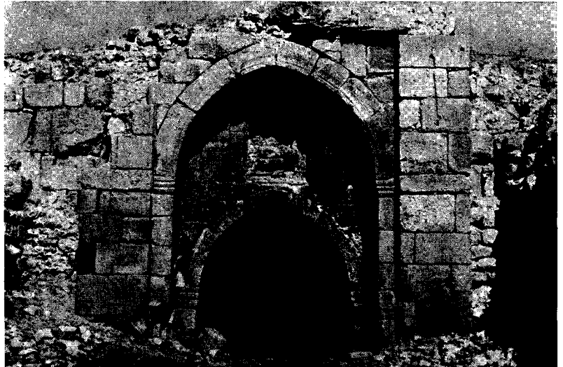
Res. 3 — Konya-Altınapa Kervansarayı kışlık girişindeki tak kapısı.
