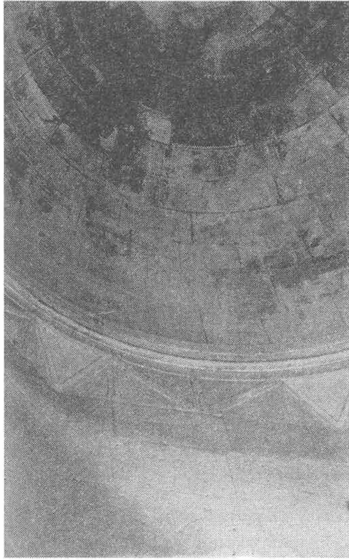
Res. 21 — Kayseri, Mahperi Hatun Türbesi Tambur ve kubbesi.
