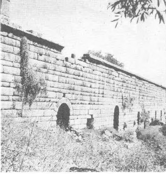
Res. 25 — Stoanın Güneye müteveccih olan muazzam cephe duvarı.
