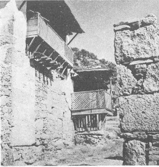
Res. 1 — Karpuzlu bucağının eski yapılardan sökülme bloklardan inşa edilmiş olan evlerinden bazıları.
