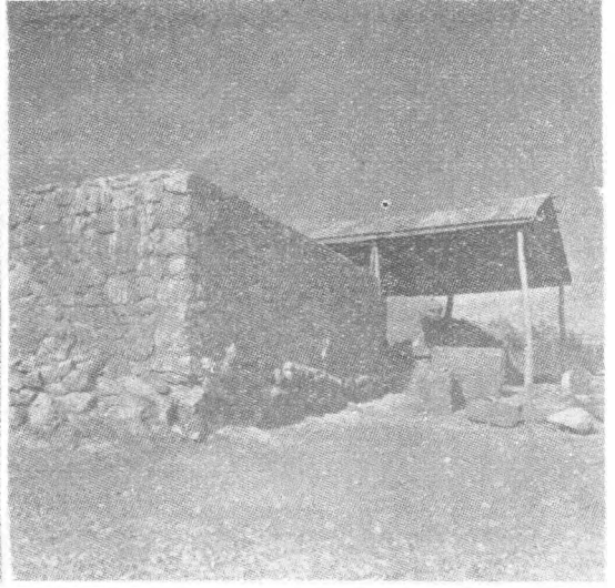
Res: 3 — Aynı burç duvarının restorasyondan sonraki hali
